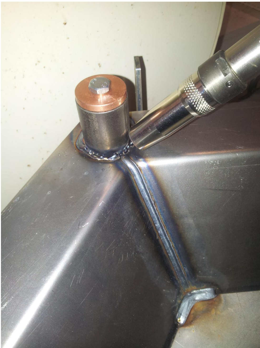
Kuva 8. Putken epäonnistunut hitsausauma.
