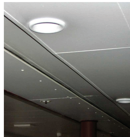
10. ja 11. Pusia poistettavia kattorakenteita, alakuvassa ilmastointiaukko
