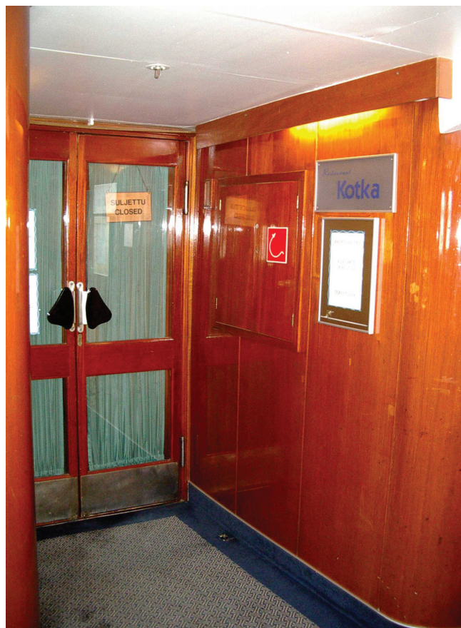
Kuva 101. Kotka -ravintolan sisäänkäynti. Kuvassa näkyvät nykyiset heiluriovet ja palopostin kaappi siirtyvät muutostyössä uusiin paikkoihin.
