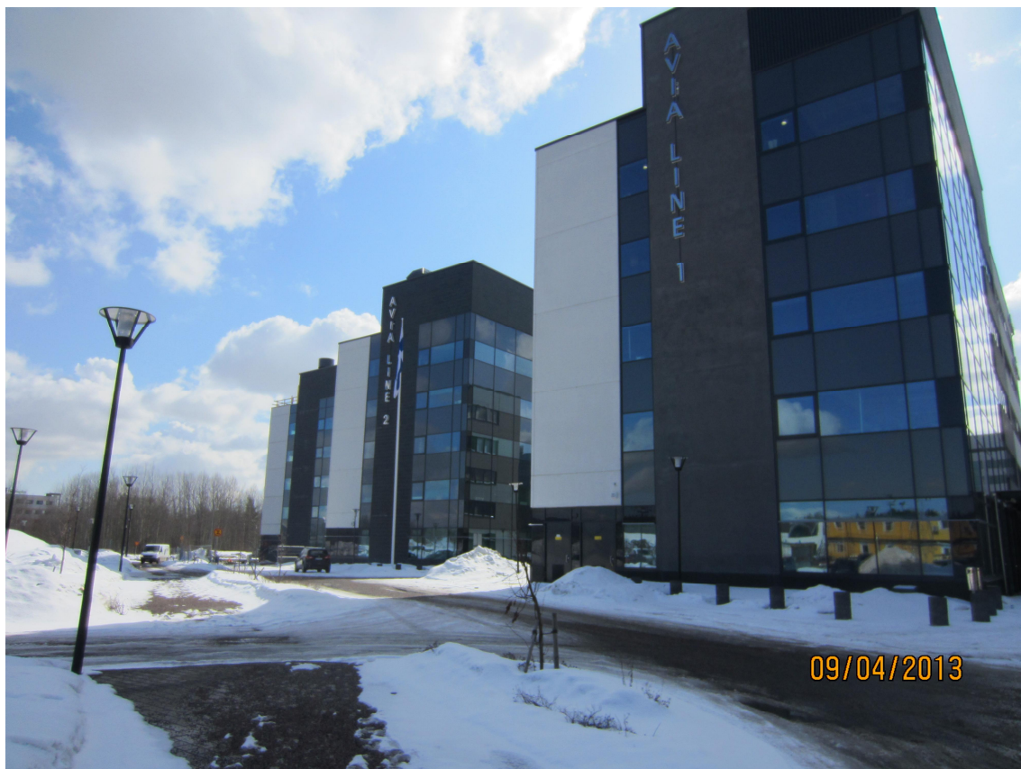
Kuva 2. Kuvassa vasemmalla Avia Line 3-toimistotalo. Oma kuva.
