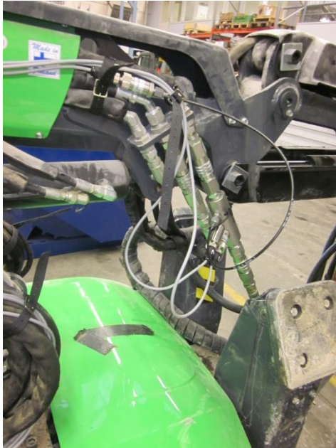
KUVA 20. Hydraulikan painetta ja tuottoa mittaava anturi kiinnitettynä robotin puoleen (Kuva: Juuso Tikka 2013)
