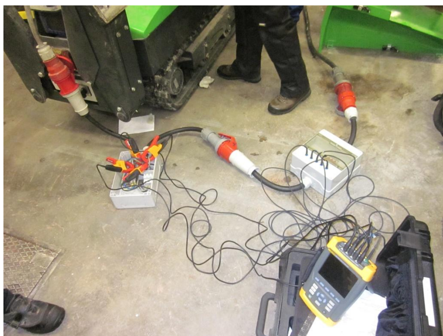
KUVA 19. Kuva mittauksesta (Kuva: Juuso Tikka 2013)
