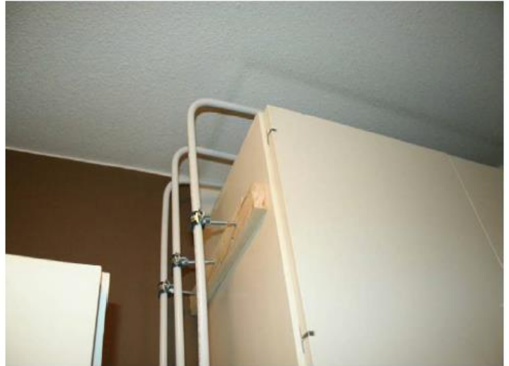
Kuva 7, Pintaan asennettuja komposiittiputkia (VTT tiedotteita 2483, sivu 48, kuva 21)
