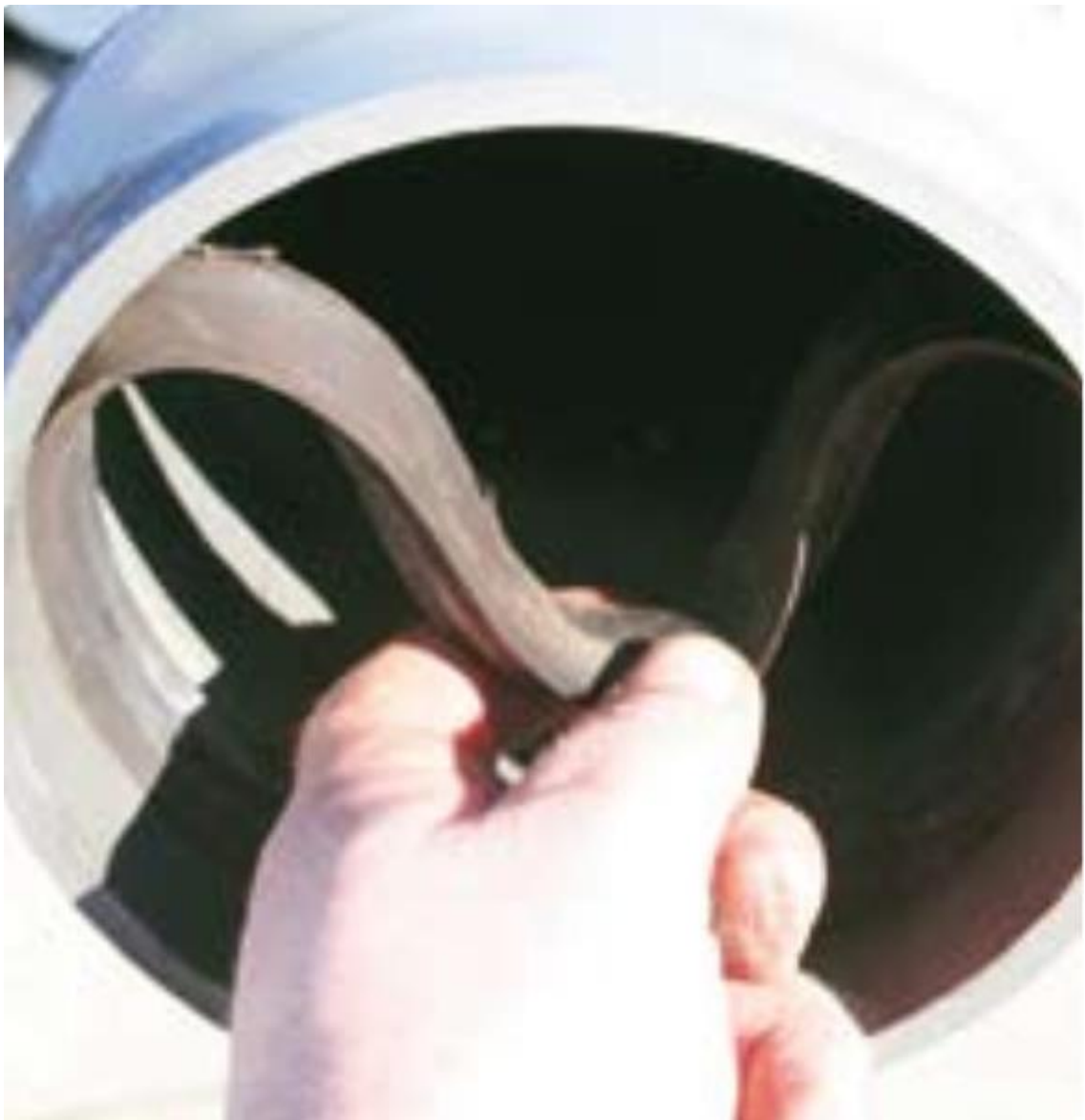
KUVA 13: Puhdas tiiviste asennetaan takaisin muhvin uraan puristamalla tiiviste ensin sydämmen muotoiseksi.
