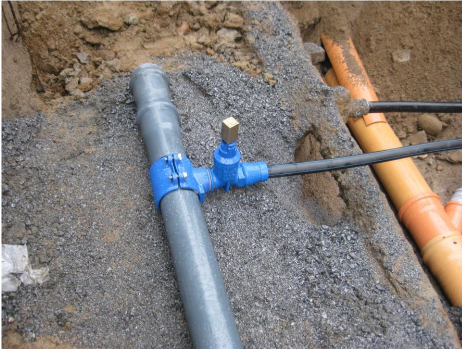
KUVA 7: Uusi vesijohdon haaraventtiili PVC-paineputkessa. Vieressä käytössä oleva valurautainen vesijohto.
