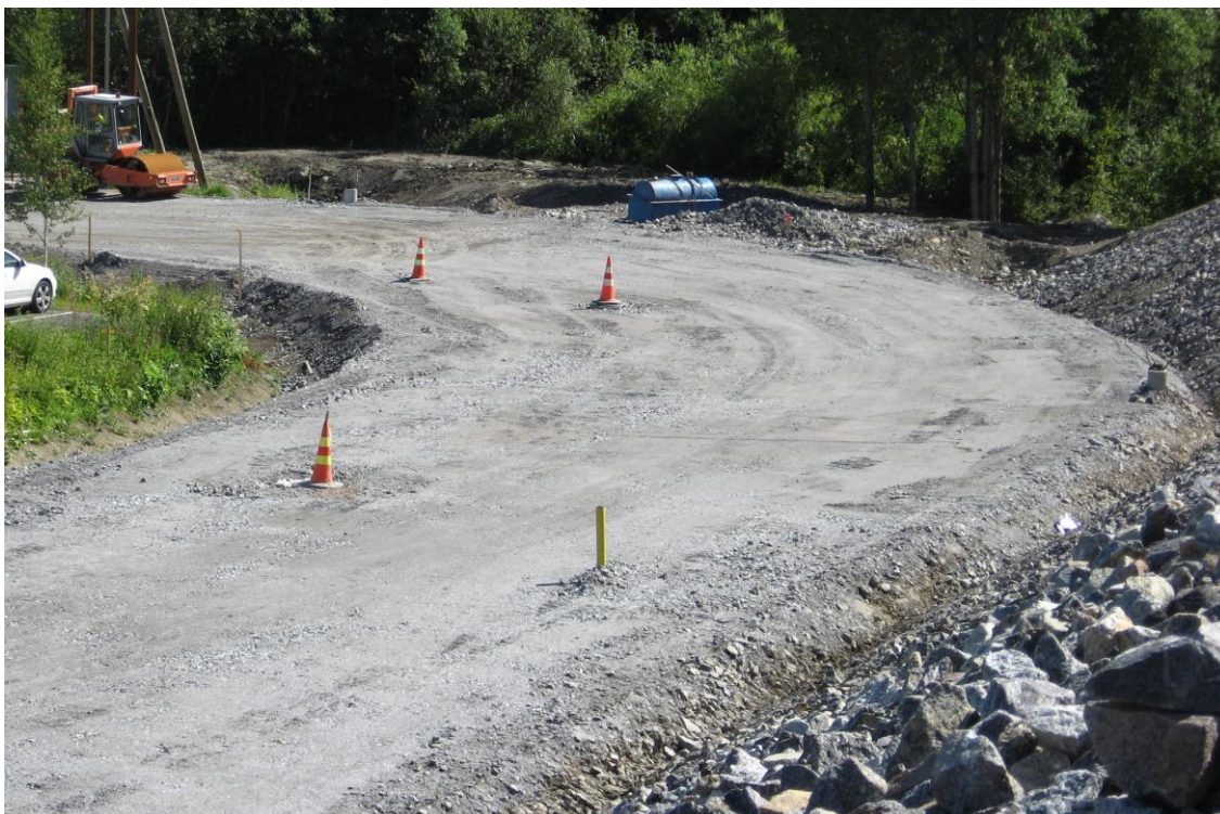
KUVA 12: Tiivistetty sitomaton kantava kerros. (Kuva: Kyösti Rajala 2012)
