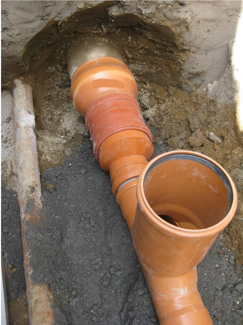
KUVA 16: Betoni-PVC jatkoyhde oikein asennettuna.
