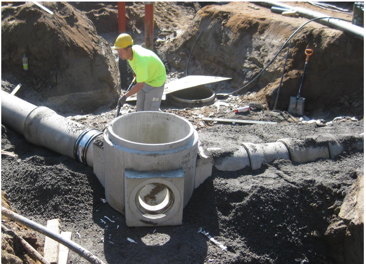
KUVA 17: Sadevesikaivon asennusta ja alkutäytön tekemistä risteysalueella.
