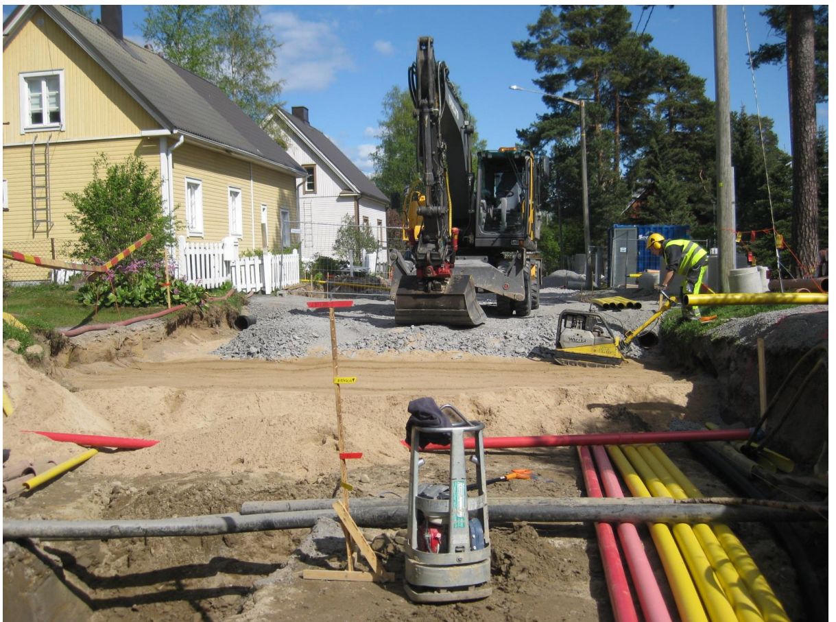
KUVA 18: Suodatinkerroksen tiivistystä 400 kg maantiivistyskoneella.
