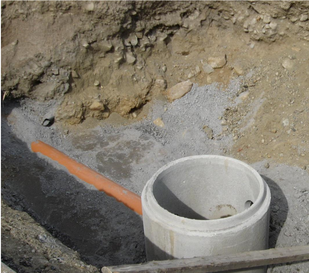
KUVA 10: Hulevesikaivon ja poistoputken alkutäyttö murskeella (Kuva: Kyösti Rajala 2012).
