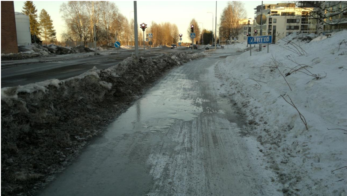
KUVA 4. Pyörätielle valuneen veden jäätyminen aiheuttaa liukkautta
