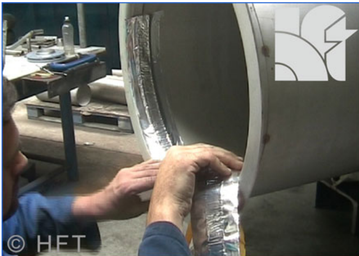
Kuva 3. Juuriteipin asennus (HFT. [viitattu 12.3.2013]).
