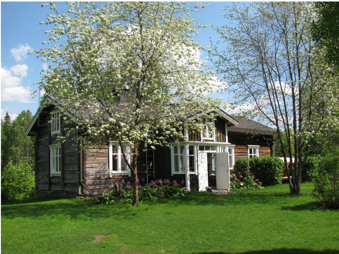
KUVA 5. Kohteen julkisivu luoteeseen
