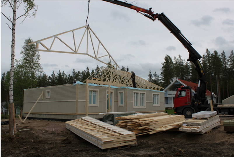
KUVA 3. Viitteellinen kuva kattoristikoiden asennuksesta (5)
