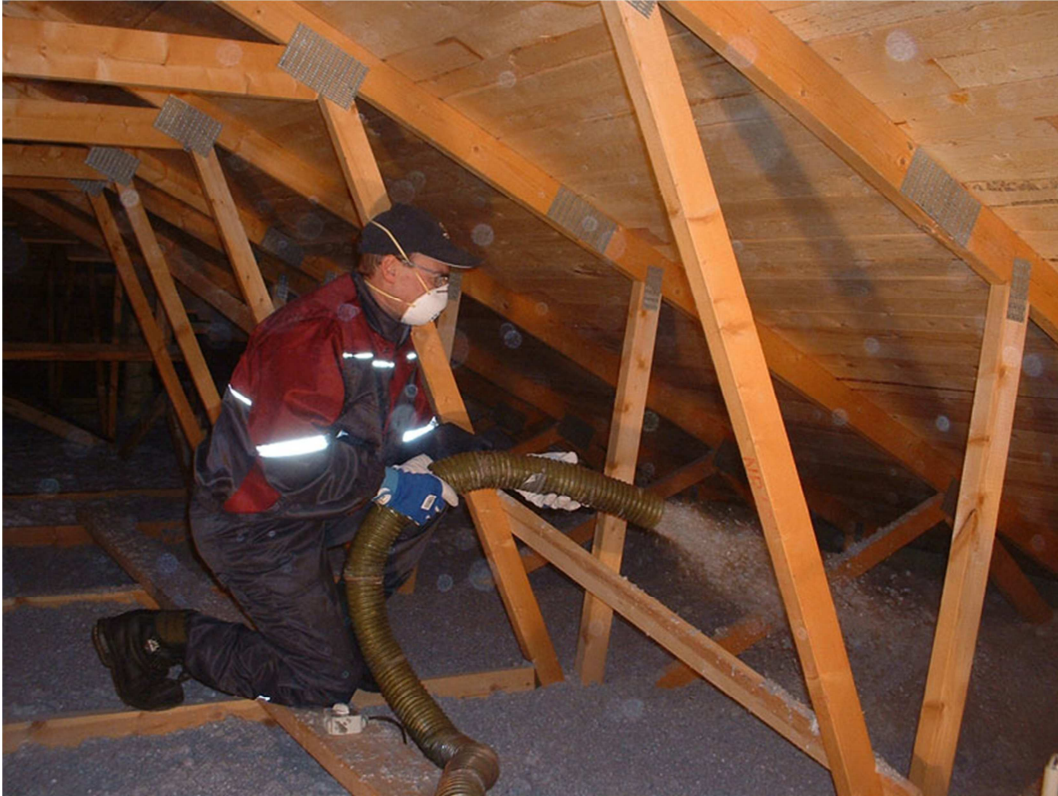
KUVA 4. Viitteellinen kuva puhallusvillan asennuksesta (6)
