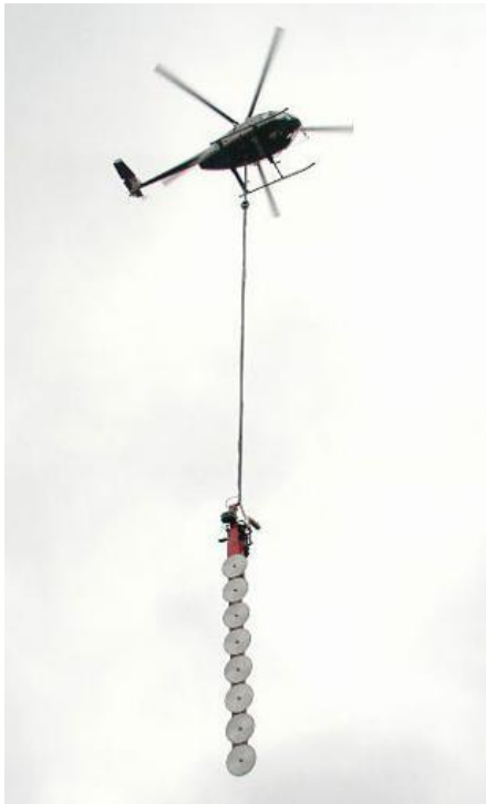
KUVA 14. Johtokadun raivaukseen käytettävä helikopteri ja linjasaha (Helitour 2013a)
