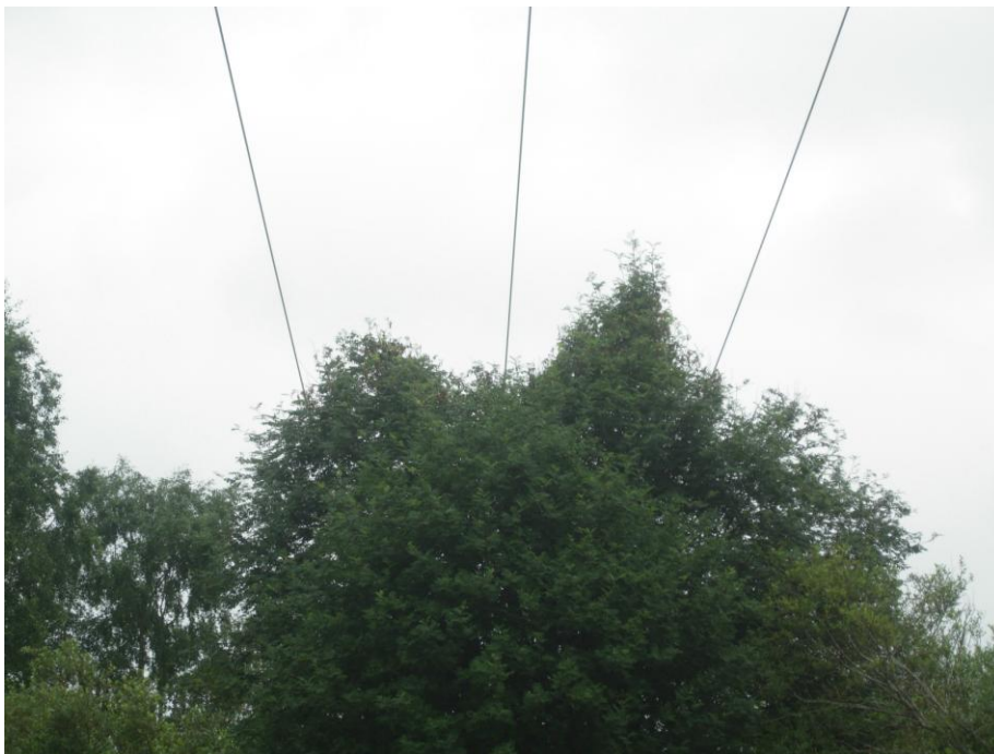
KUVA 6. Maasulkuvirtojen vahingoittama puurykelmä
