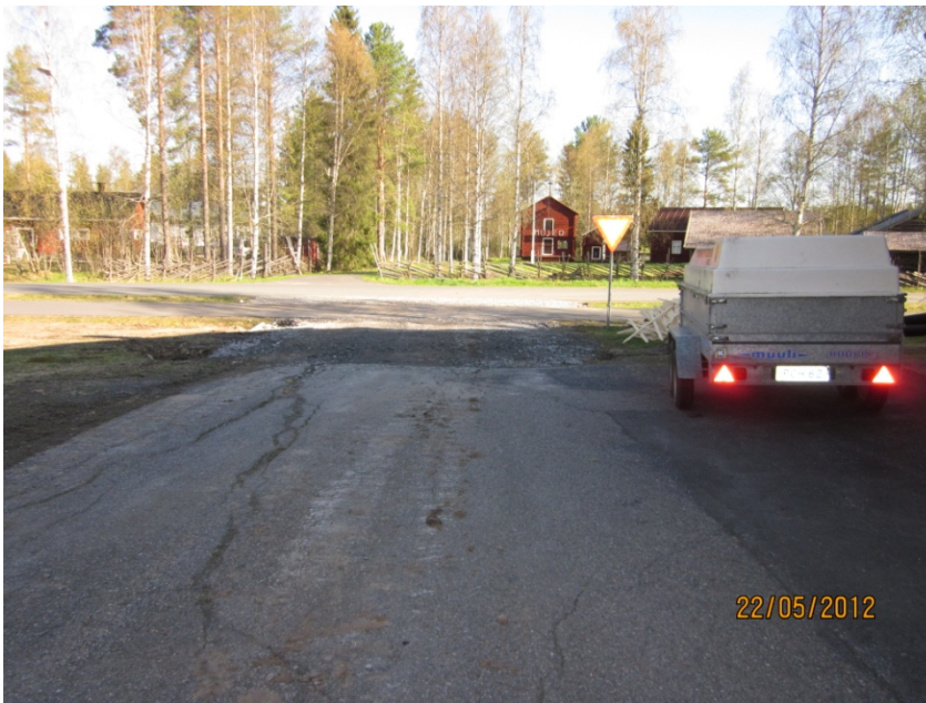
KUVA 5. Palolaitoksen väliaikainen liittymä
