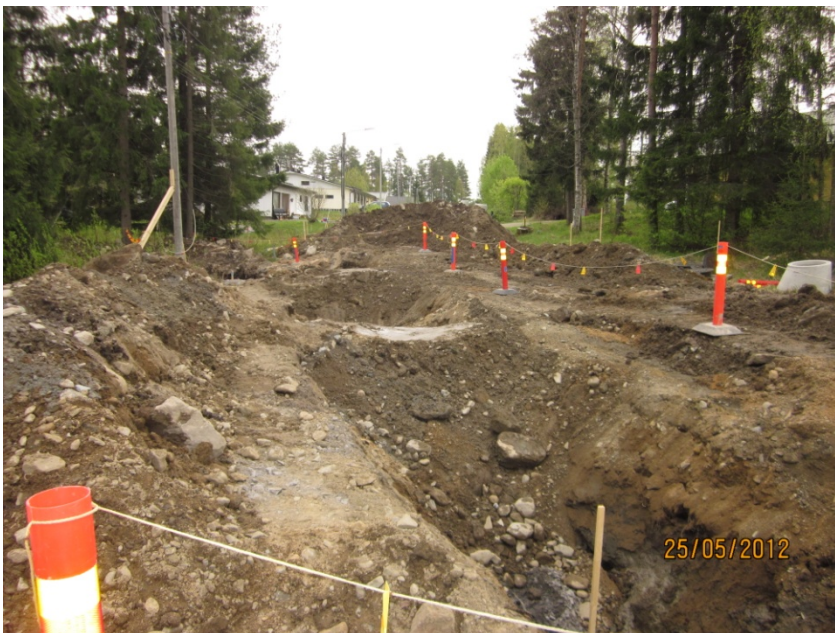
KUVA 7. Kaivantosuojauksia
