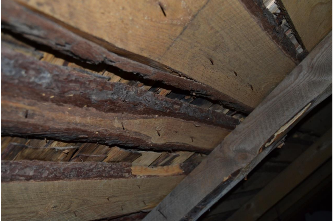
Kuva 11. Alin kattorakenne eli pärekatto kuvattuna kylmältä ullakolta. Kuva: Ossi Kauppinen 2012.
