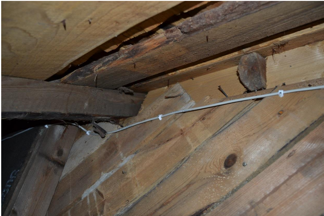
Kuva 10. Vesikaton ja vinon yläpohjan välinen laudoin tukittu tuuletusväli. Kuva: Ossi Kauppinen 2012.
