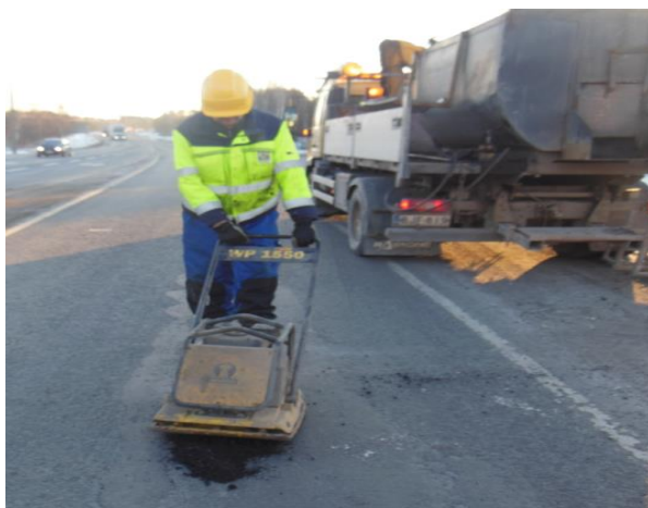
KUVA 31. Päällystepaikkauksen tiivistämistä (Kuva: Juha Poskiparta 2013).
