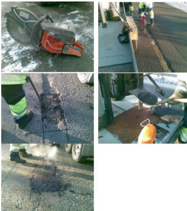
KUVA 27. Valuasfalttipaikkaus, paikkauskohdan käsittely ja massan valu (Huuskonen ym., 2009)
