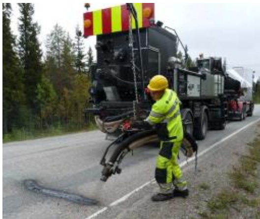
KUVA 34. Sirotepuhalluspaikkaus (Päällysteiden paikkaus 2009)
