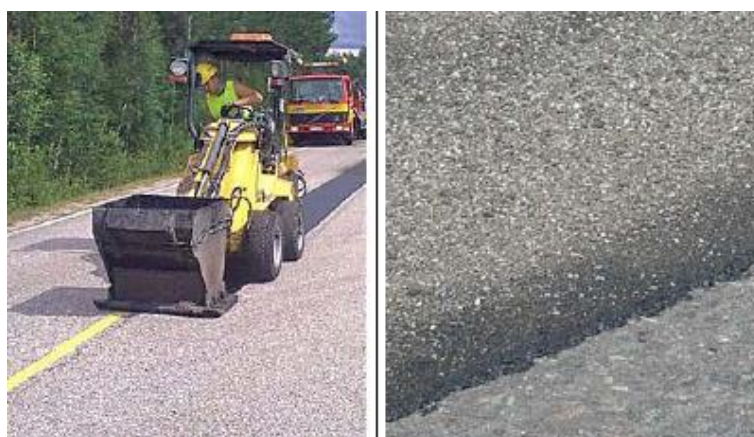
KUVA 30. KT- valuasfalttipaikkauksen levitys, tiivistys ja karkeutettu paikkaus (Päällysteiden paikkaus 2009)
