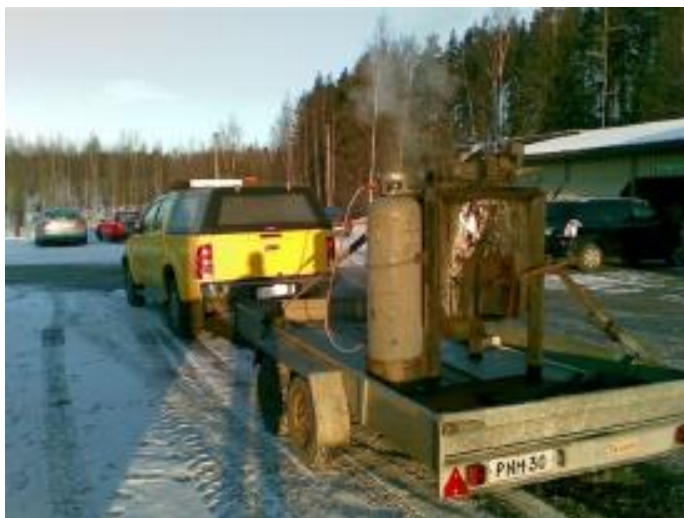
KUVA 28. Teliperäkärriyn lavalle liinoilla sidottu nestekaasulla lämmitettävä valuas- falttipata (Huuskonen ym., 2009)
