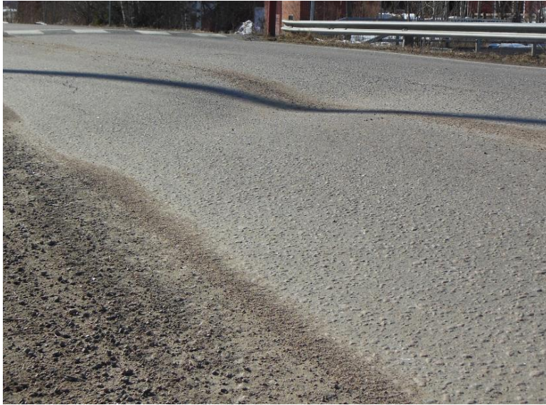
KUVA 40. Routaheitto tiessä (Kuva: Juha Poskiparta 2013).
