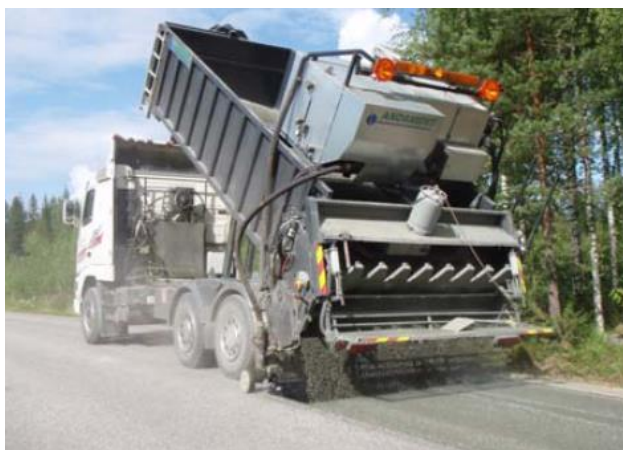
KUVA 33. Sirotepaikkaus (Päällysteiden paikkaus 2009)
