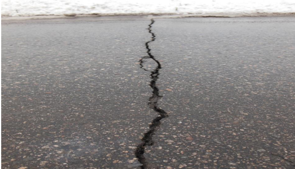
KUVA 16. Poikittaissuuntainen routahalkeama (Kuva: Juha Poskiparta 2013).
