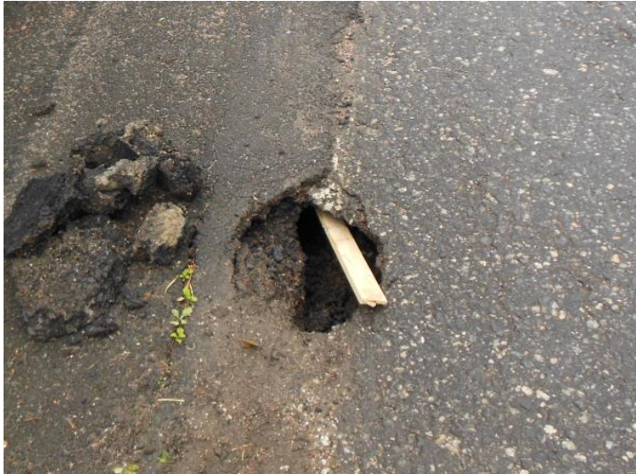
KUVA 38. Rummun rikkoutumisen aiheuttama eroosioaurio tierakenteessa (Kuva: Juha Poskiparta 2012).
