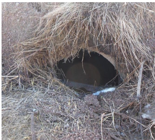
KUVA 37. Hoitamaton päätierummu (Kuva: Juha Poskiparta 2013).
