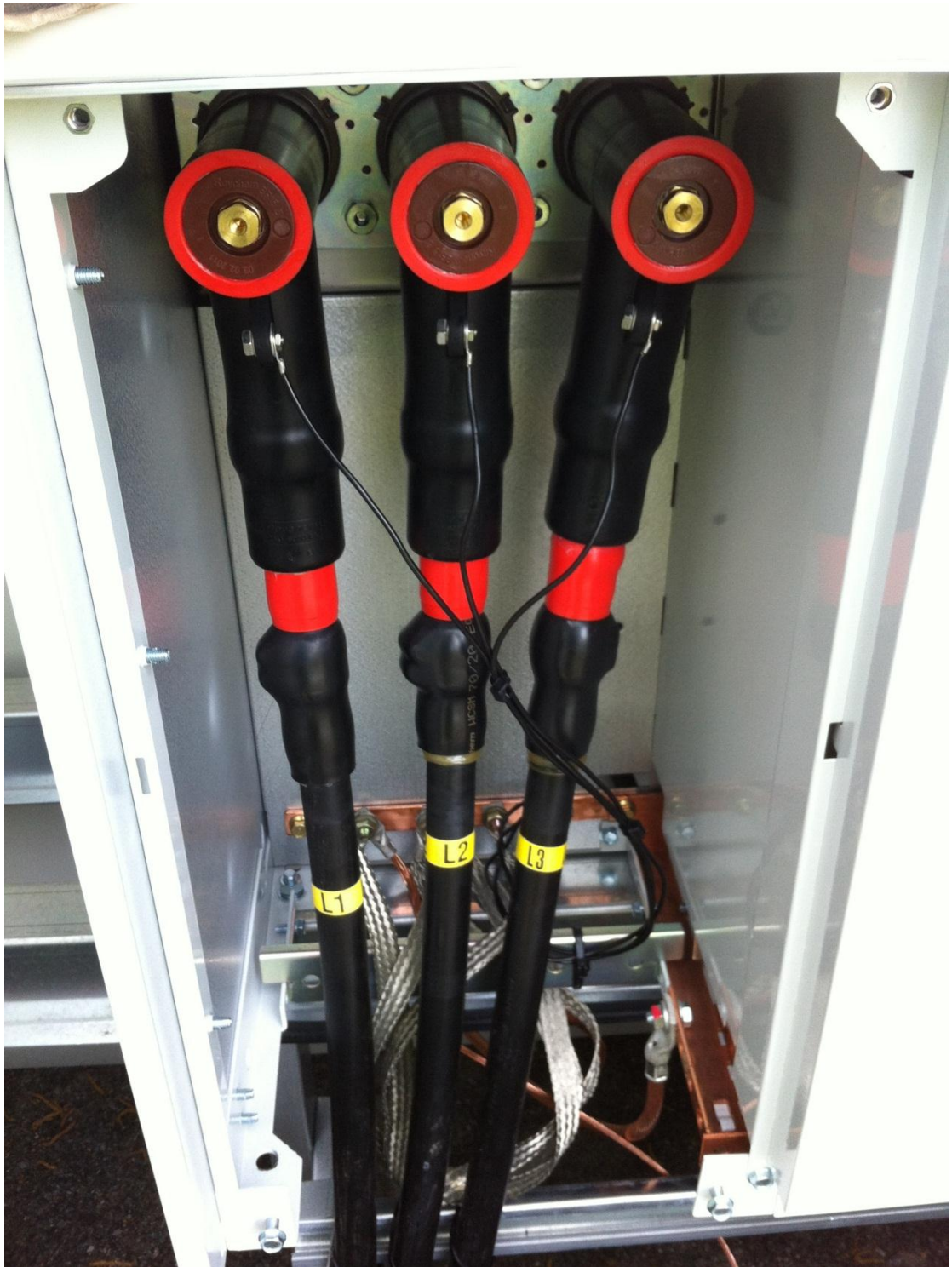
KUVA 9. Kaapelin päätet kytettyinä
