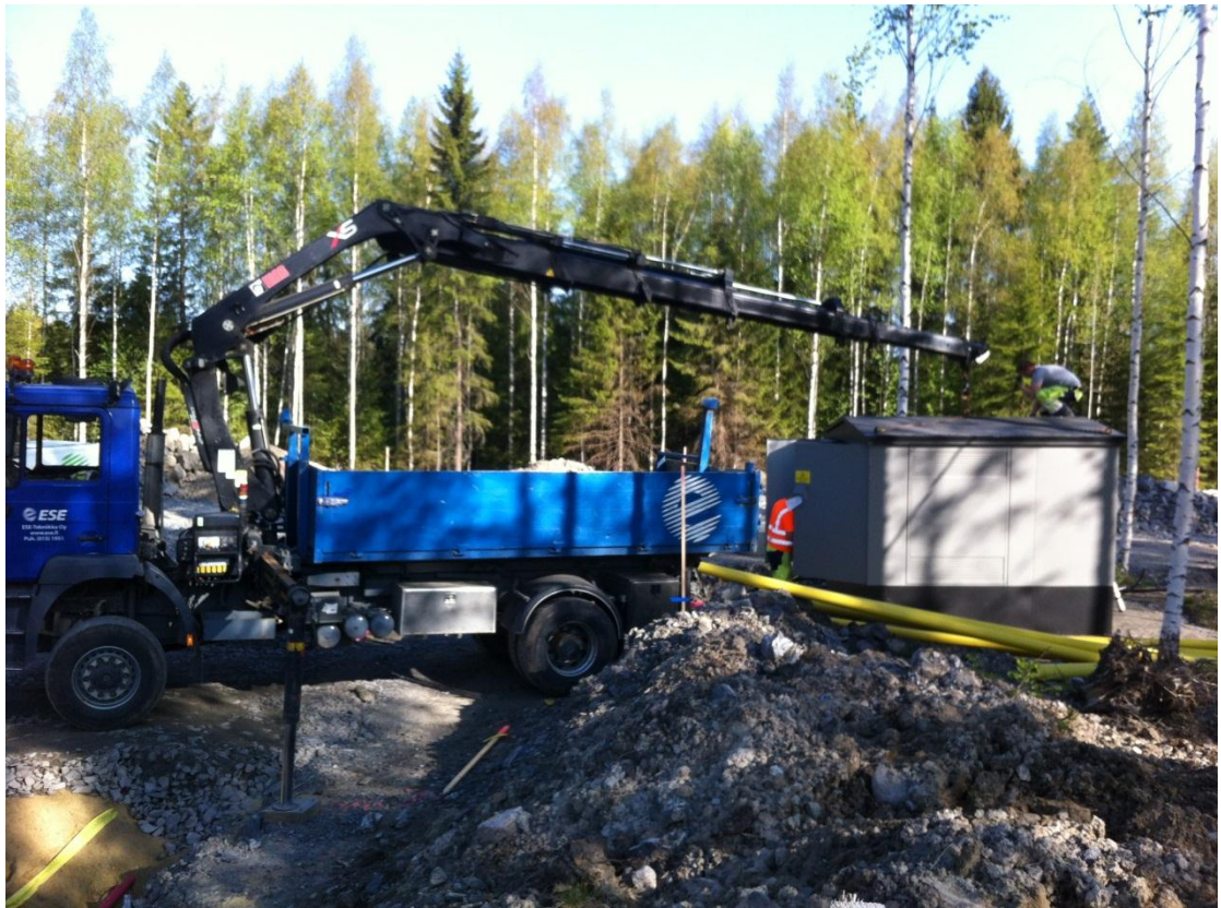
Kuva 7. Muuntamokoppi nostettuna paikalleen Vuolingolla
