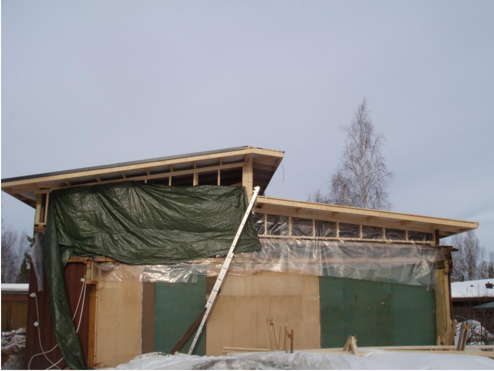
Kuva 31. Uuden katon rakentaminen etenee.
