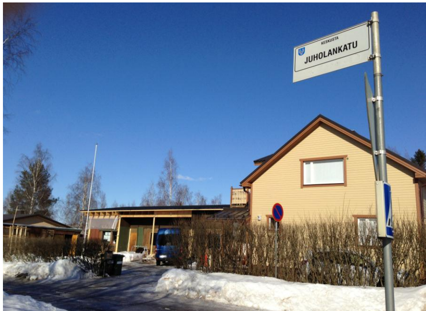
Kuva 1. Näkymä Juholankadulta. Taustalla näkyy opinnäytetyöni kohde. Työmaa on jo käynnissä.
