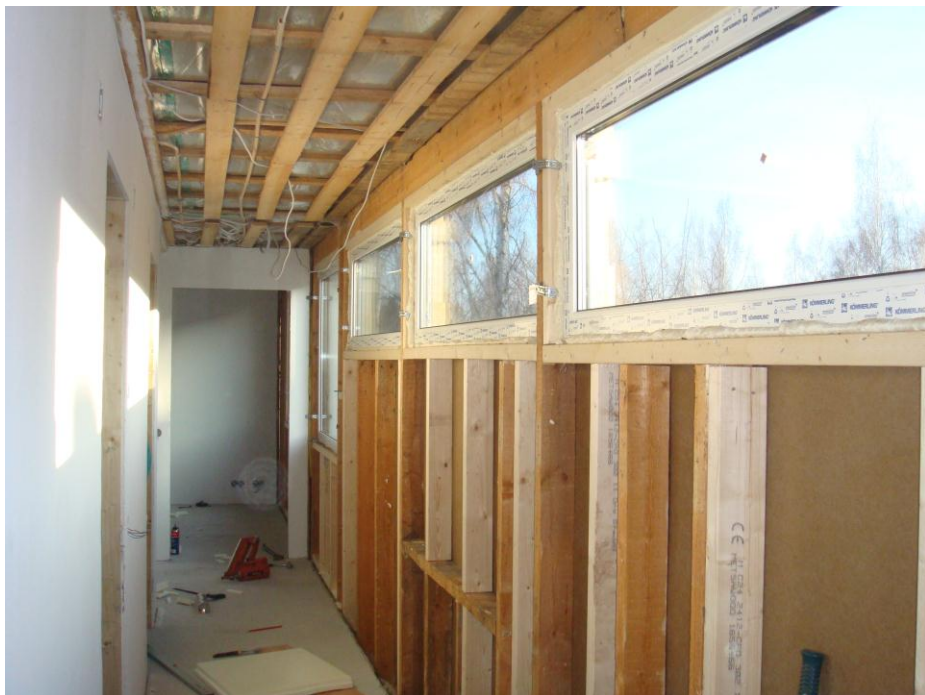
Kuva 34. Käytävän ikkunoiden asennusta
