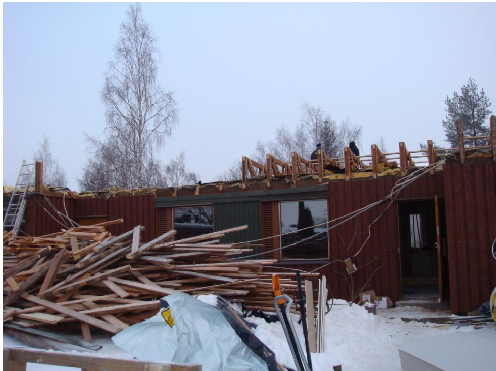
Kuva 30. Alkuperäistä kattoa puretaan.
