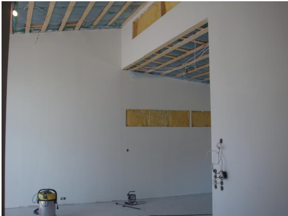
Kuva 33. Sisätilat edistyvät ja ikkuna aukotukset on tehty.
