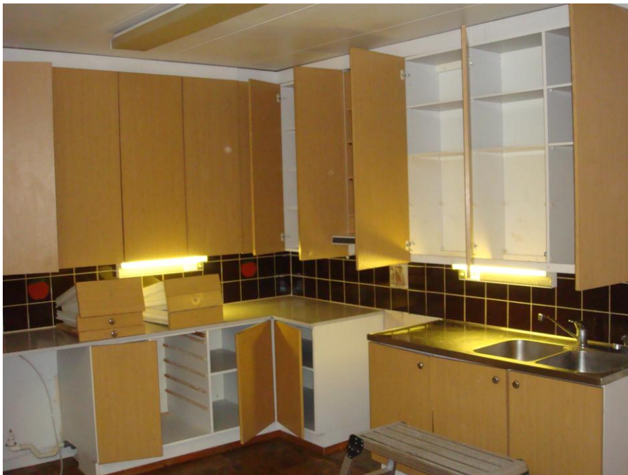
Kuva 28. Alkuperäisen paritalon keittiötä puretaan.
