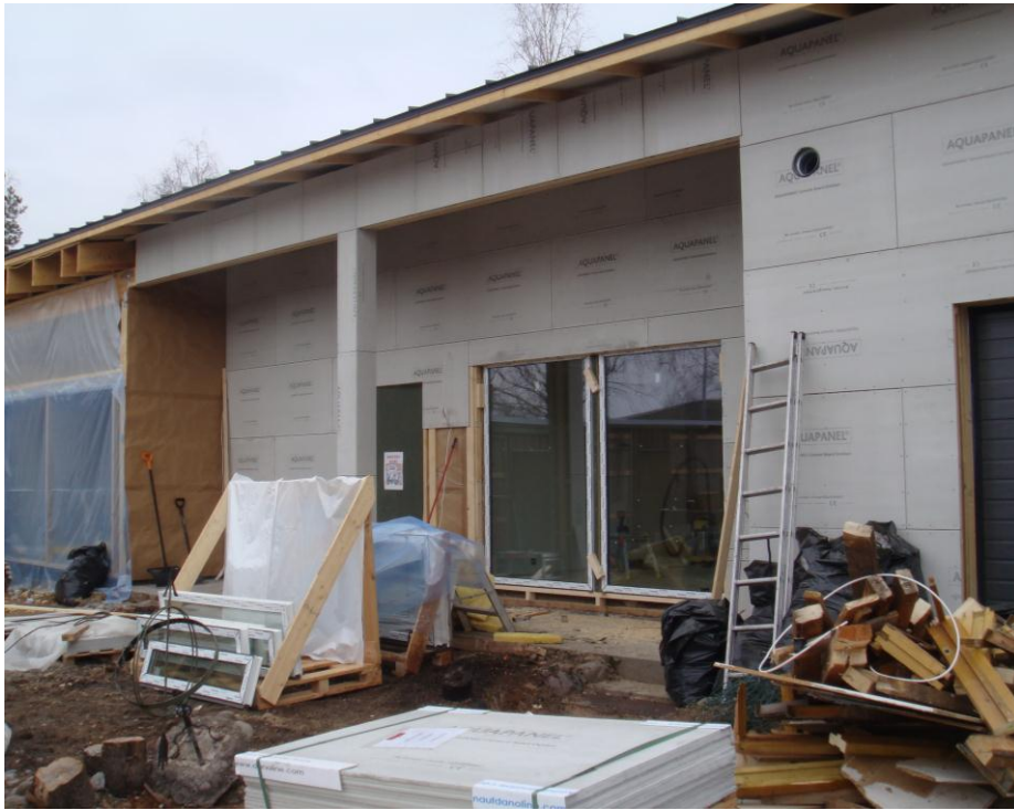
Kuva 35. Ikkunoiden asennusta. Kuvassa näkyy makuuhuoneen ja olohuoneen ikkunat ja ikkuna-aukot.
