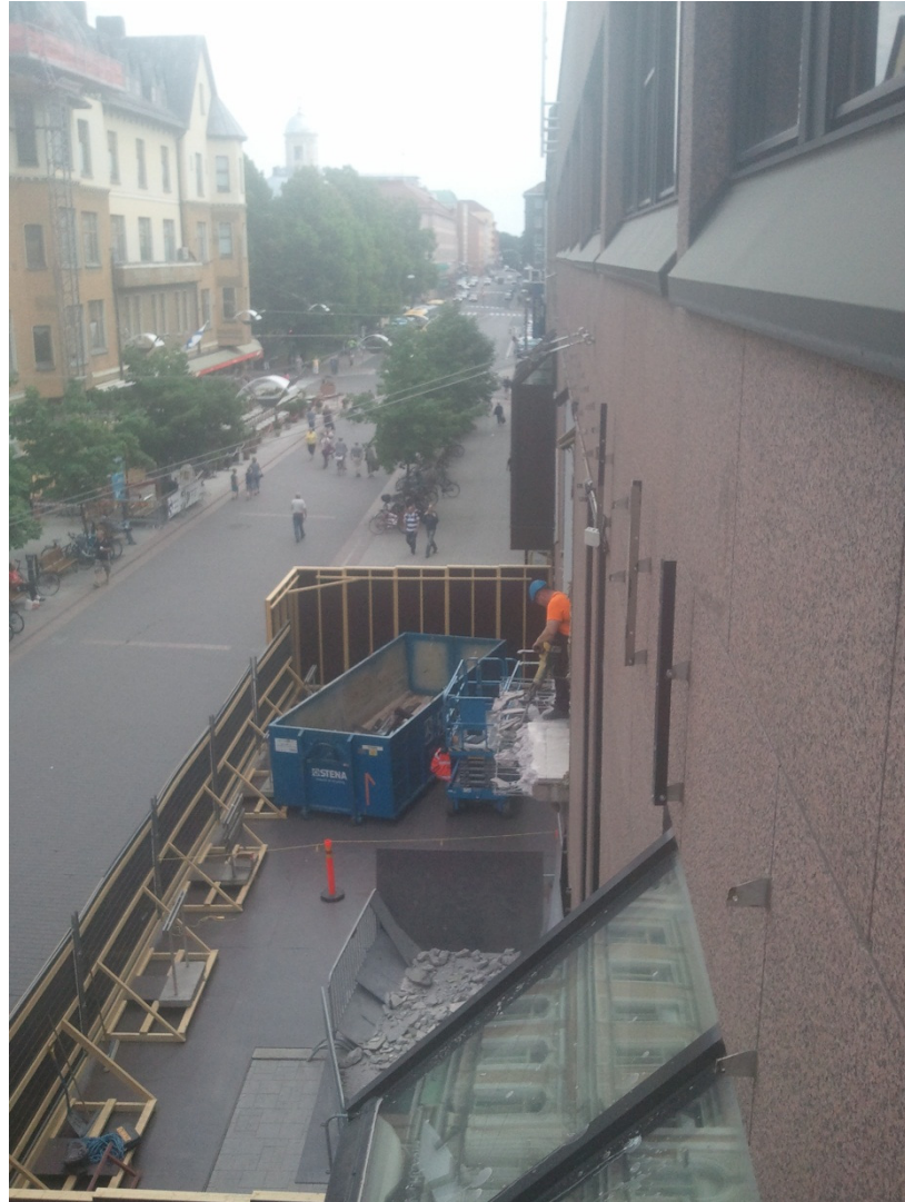
Kuva 3. Yliopistonkatu on erotettu työmaa-alueesta suoja-aidoin.
