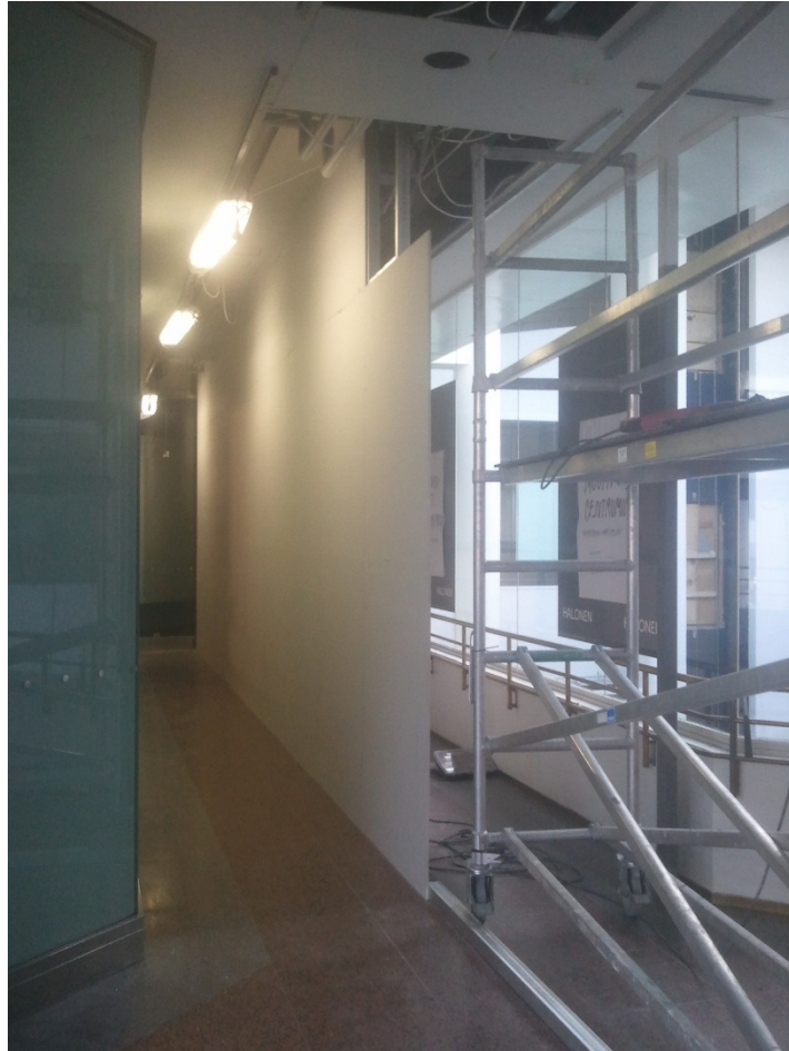
Kuva 2. Palo-osastoiva suojaseinä rakenteilla työmaan ja kauppakeskuksen välille.
