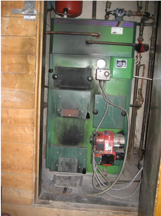
Kuva 3. Puu-öljy-yhdistelmäkattila
