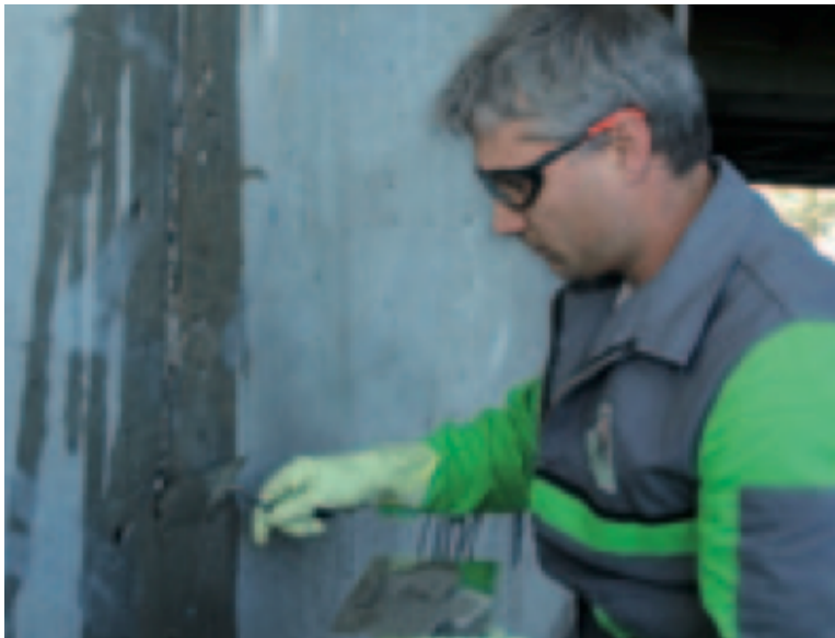
KUVA 16. Halkeaman sulkeminen (Halkeamien korjaus sekä injektointimenetelmät, 8)
