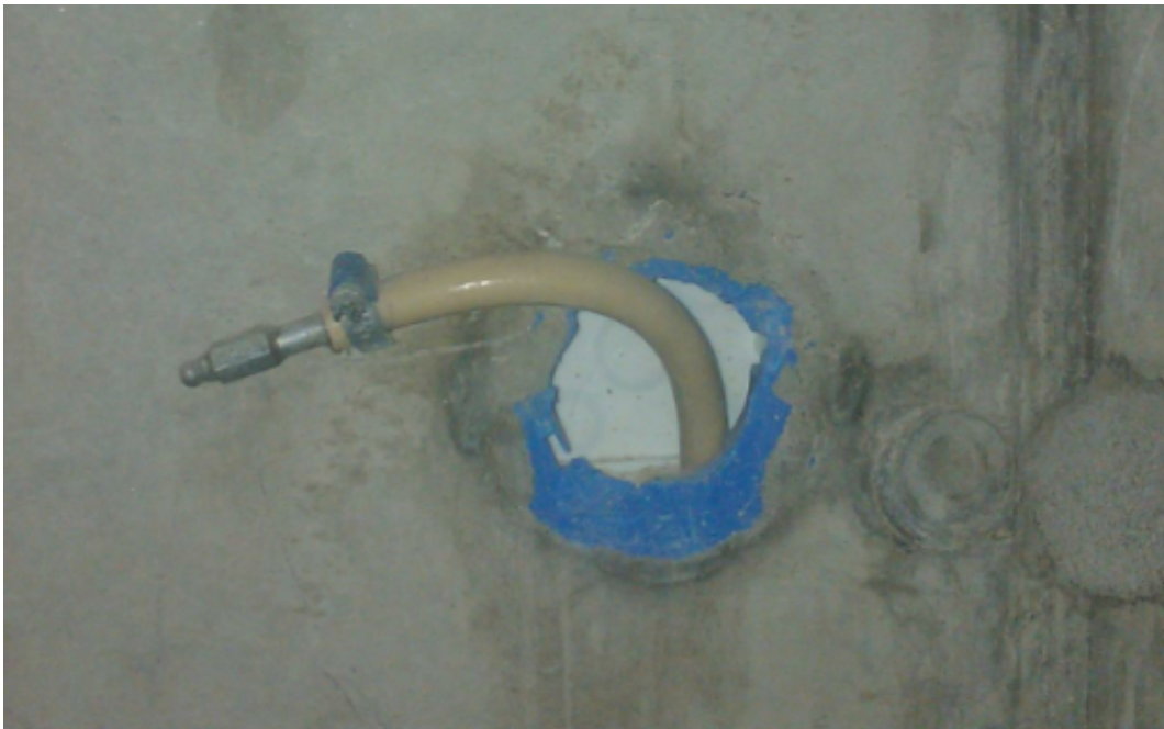
KUVA 9. Injektointinippa asennettuna syöttöletkuun
