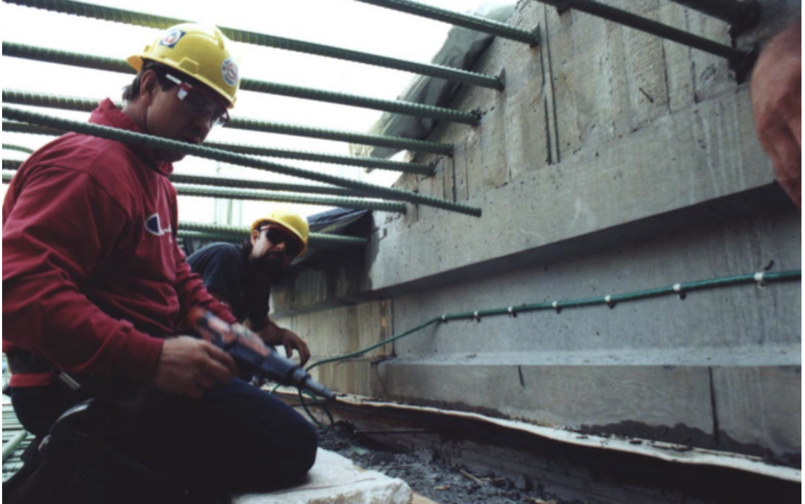
KUVA 4. Injektointiletkun kiinnitys (Joco 10 Injektointi, 5.)
