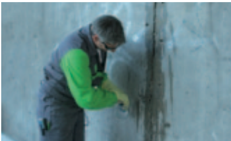
KUVA 15. Halkeaman esikastelu (Halkeamien korjaus sekä injektointimenetelmät, 8)
