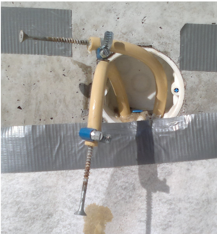
KUVA 10. Injektointiletkun tukkiminen ruuvilla ja letkukiristimellä
