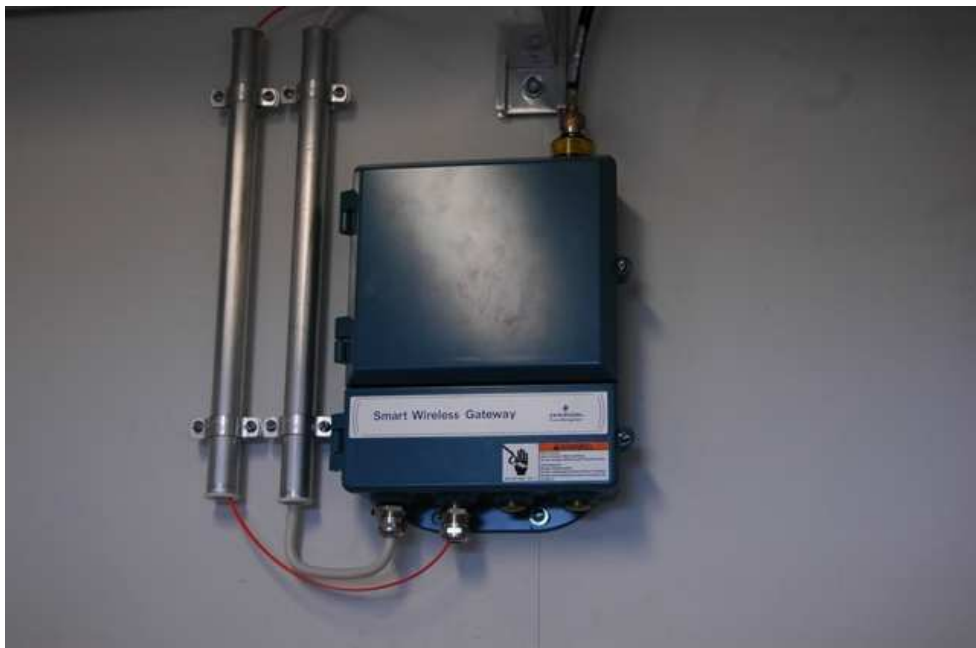
KUVA 29 Gateway asennettuna muuntamorakennukseen
