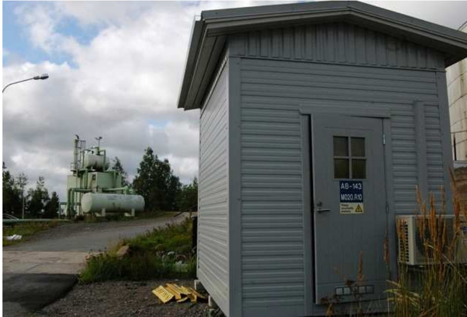
KUVA 30 Muuntamo- ja kattilarakennus
