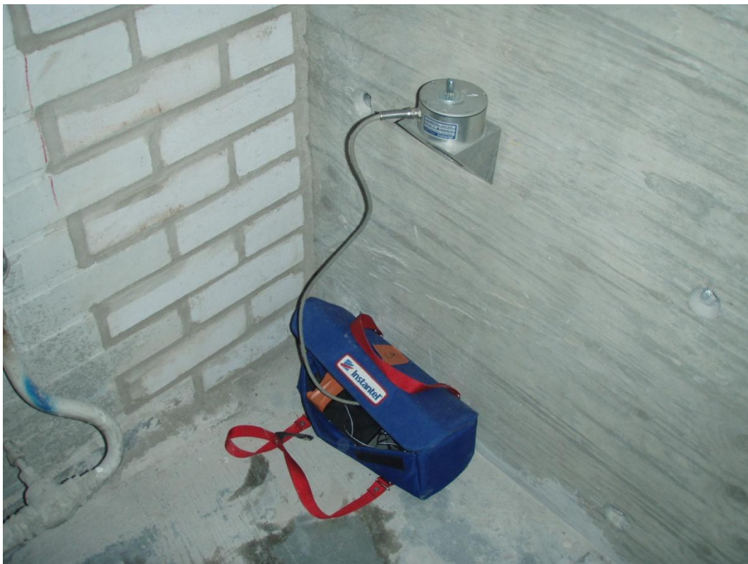
Kuva 5. Tärinämittari betonipilarissa City-Centerissä
