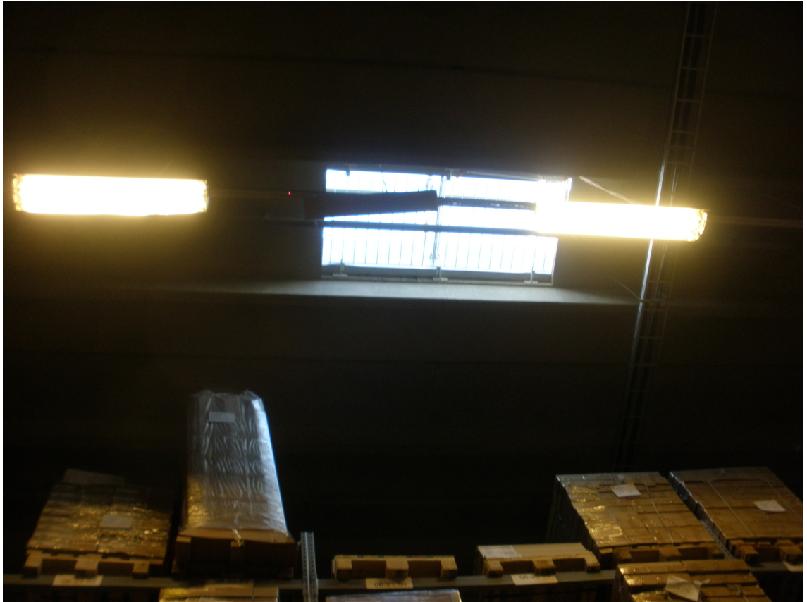
Kuva 14. Pre-Site Surveyn aikana halutut tukiasemien paikat merkattiin laserosoitimella, josta otettiin kuva. Kuva on otettu korkeavarastosta, jossa haluttu tukiaseman paikka sijaitsee kahden lampun välissä, jossa pieni punainen piste näkyy.
