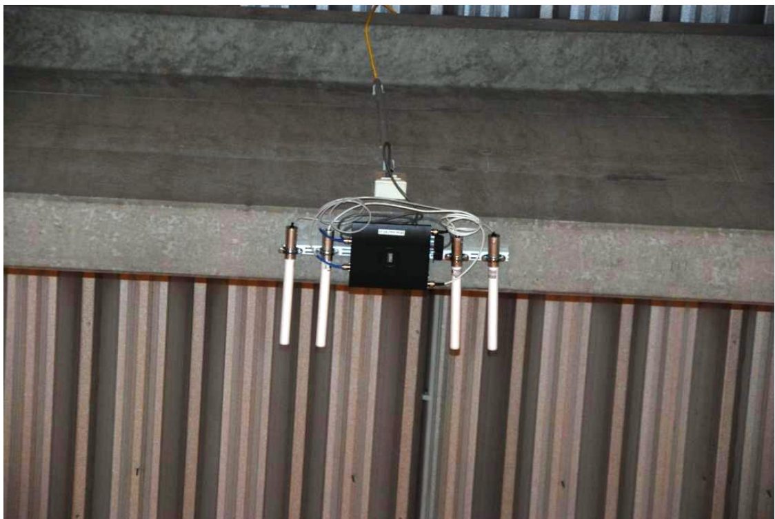
Kuva 16. Tässä kuvat ohjeesta, kuinka antenni-tukiasema yhdistelmä tulisi esimerkiksi asentaa korkeavaraston tiloihin. Ylhäällä näkyy, miten antennit (ANT2506 ja ANT5160V) asennetaan niin, ettei kahta samantaajuista antennia ole laitettu vierekkäin.
