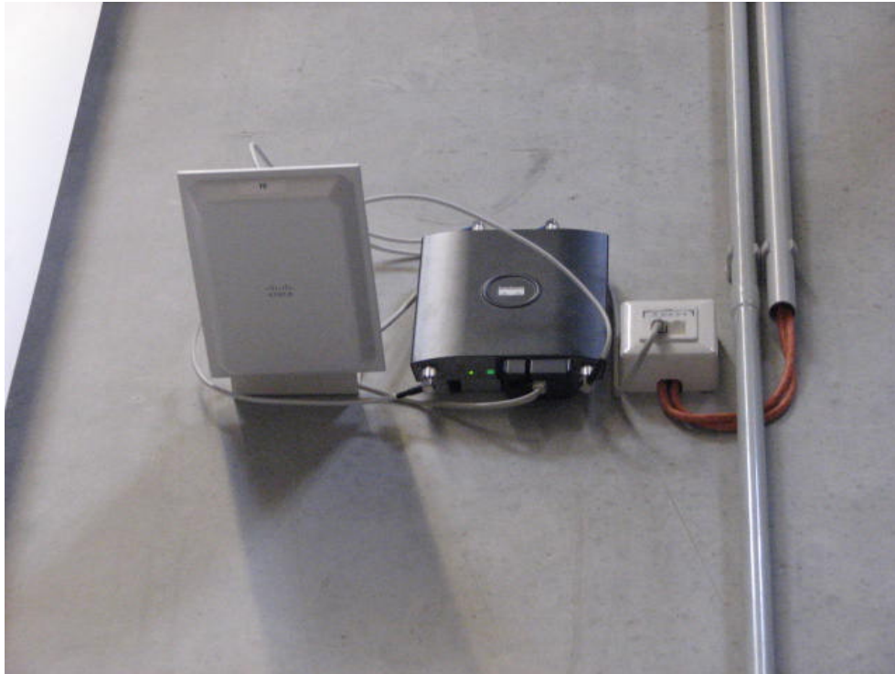
Kuva 40. Antenni on asennettu vaakatasoon, mutta pitäisi asentaa pystysuoraan kuten tukiasemakin on asennettu.
