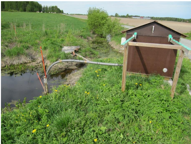
Kuva 4. Sumppilammen kosteikon näytteenottokoppi. Kuva Jussi Haapamaa 2012.
