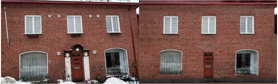
Kuvio 28. Okklusion poisto. Vasemmalla alkuperäinen kuva ja oikealla versio, josta on poistettu kaikki ylimääräinen, jota ei haluta 3D-talon pintaan. Tällainen teksturi voidaan projisoida 3D-malliin, josta syntyy mallin teksturi. Pylväät, katokset, ovet ja ikkunat mallinnetaan erikseen ja niihin luodaan omat tekstuurit.
