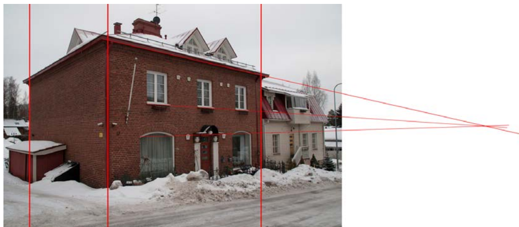
Kuvio 4. Kuvassa on vedetty suorat viivat horisontin pakopisteeseen. Rivissä olevat ikkunat asettuvat samalle viivalle ja räystääs on suorana viivaa pitkin. Tästä tiedämme, että sivusuunnassa kuva on kohdallaan. Kun seinät vielä kulkevat suorien pystyviivojen mukaisesti voimme varmuudella sanoa, että ainakin suurimmat linssivääristymät ovat kuvasta korjattu.
