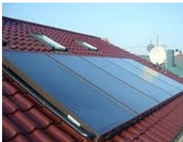
KUVIO 11. Tasokeräin asennettuna omakotitalon katolle (Viessman aurinkolämpötuotteet n.d.)
