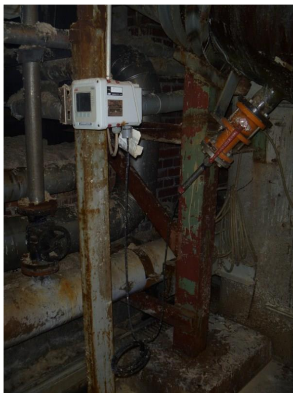
KUVA 3. QC2259 D 0 -massan pH-lähetin ja anturi.
