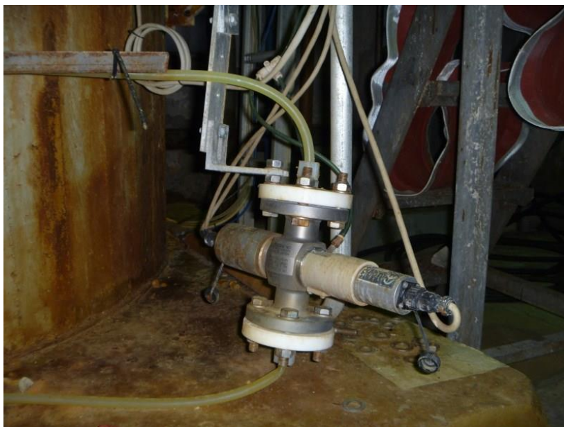
KUVA 7. QI2473 CIO 2 -veden väkevyyssmittaus.
