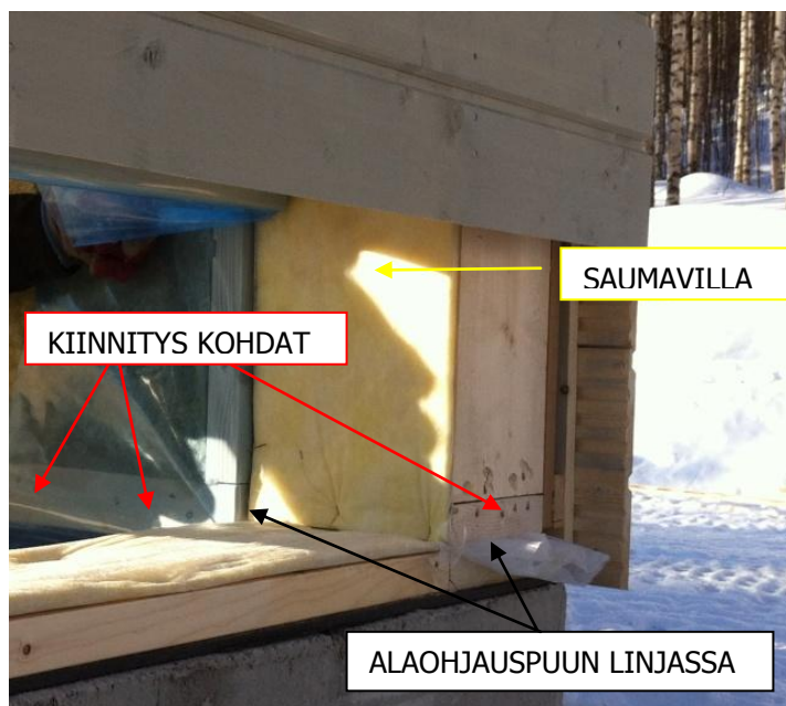
KUVA 4. Elementin asennus. Kuva Huttunen Osmo 2013
