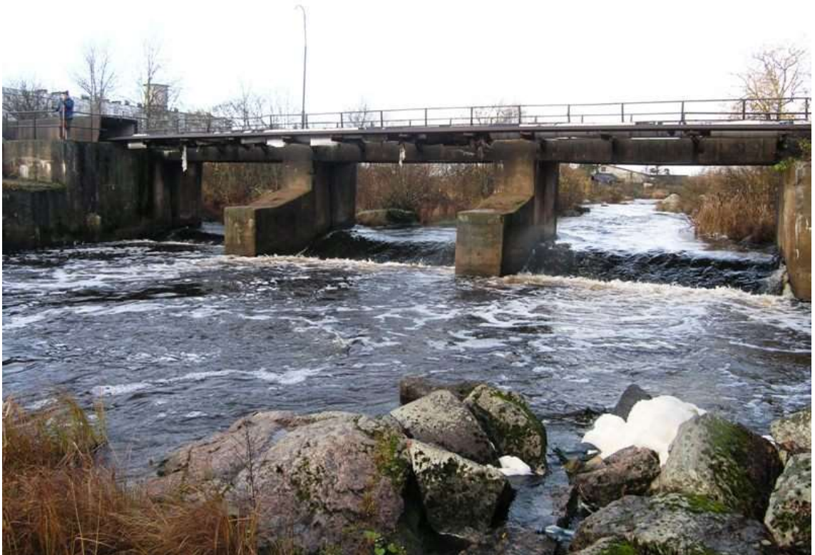
Kuva 6. Ykspäänkosken pato ei enää muodosta täydellistä nousuestettä. (Kuva: Kaakkois-Suomen ELY-keskus, syyskuu 2010.)
