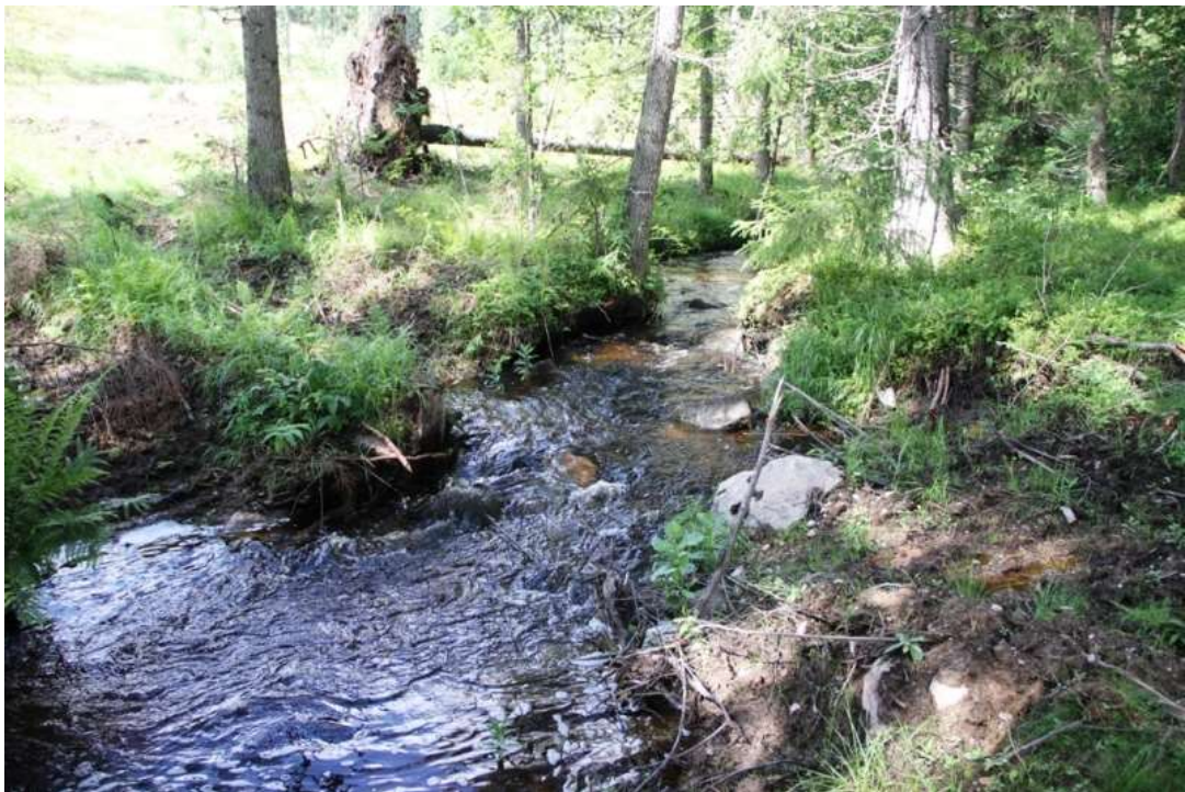
Kuva 31. Siltakosken alaosaan muodostunut syväne.
