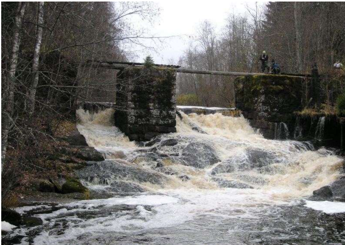
Kuva 10. Kintereenkosken pato on täydellinen nousueste (Kuva: Kaakkois-Suomen ELY-keskus, syyskuu 2010).
