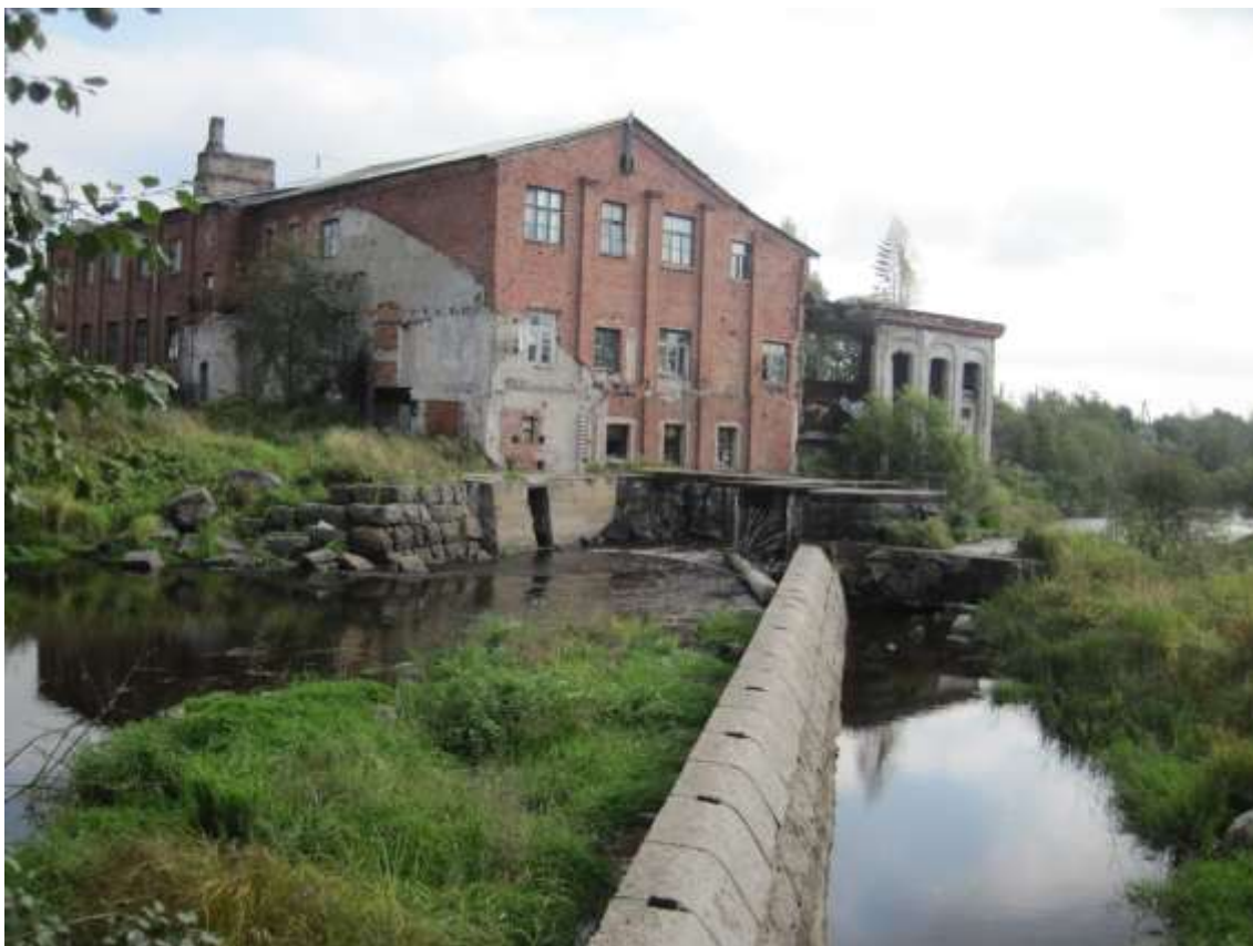
Kuva 7. Kapakkakosken ylisyoksypadon yläpuolinen vedenpinta on laskenut settiluukkujen alettua romahtaa. (Kuva: Kaakkois-Suomen ELY-keskus, syyskuu 2012.)
