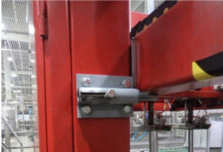
KUVIO 9. Tappi estämässä varastoituneen energian aiheuttamaa vaaraa
