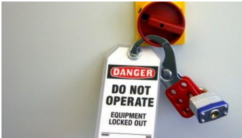
KUVIO 7. Turvakytkin energiaa eristävänä laitteena, jossa lukitus- ja merkintälaitteet (TagLink 2013)
