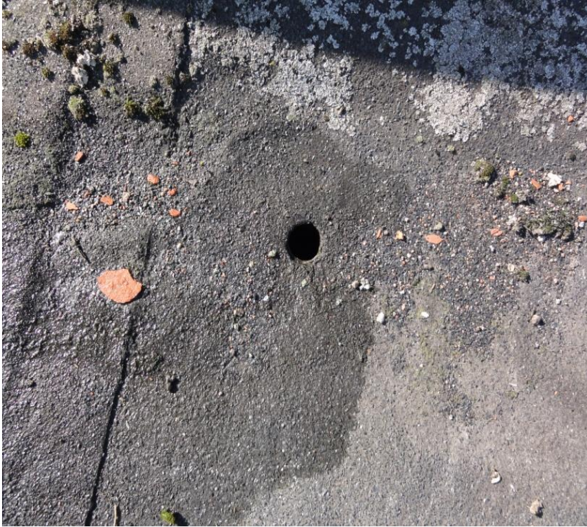
Kuva 9. Sadevesiviemärin aukon halkaisija on 40 mm
