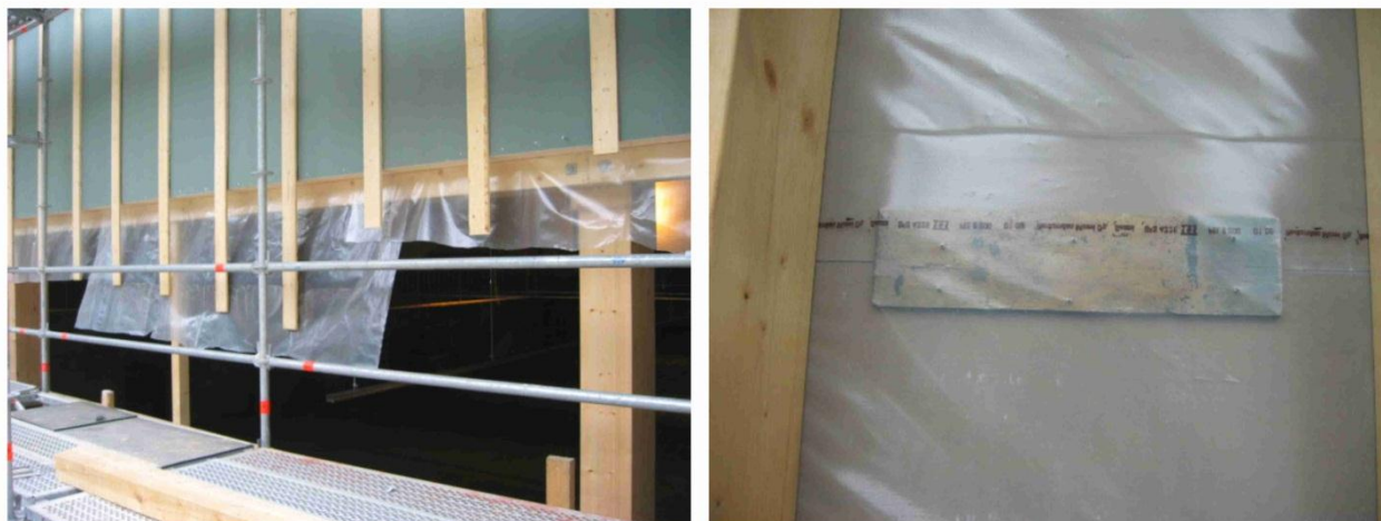
Figur 23. Vanlig plast (vänster) och ångspärrsplast (höger). (Rakennusvirhepankki 2008).
