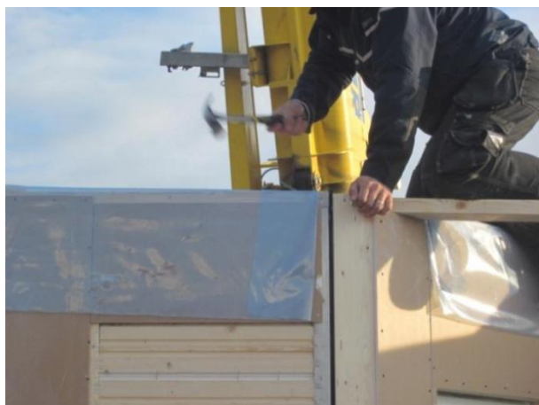
Figur 26. Kontrollera att elementen är täta innan skråspikning. (Hemming 2012).
