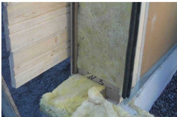
Figur 25. Elementskarv i hörn.
