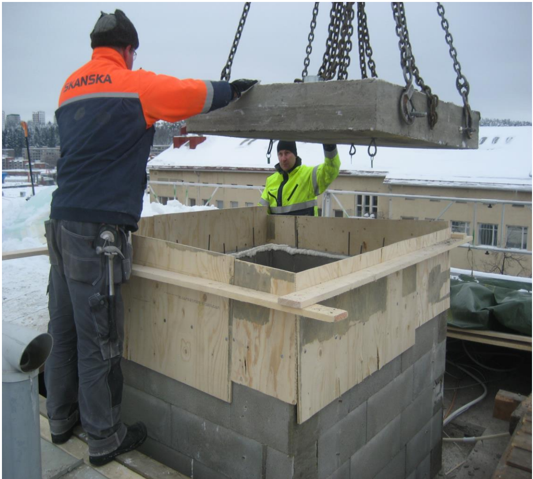
Kuva 4. Hissikuilua on jatkettu ullakon läpi vesikatolle ja siihen asennetaan uusi kansi.(3)
