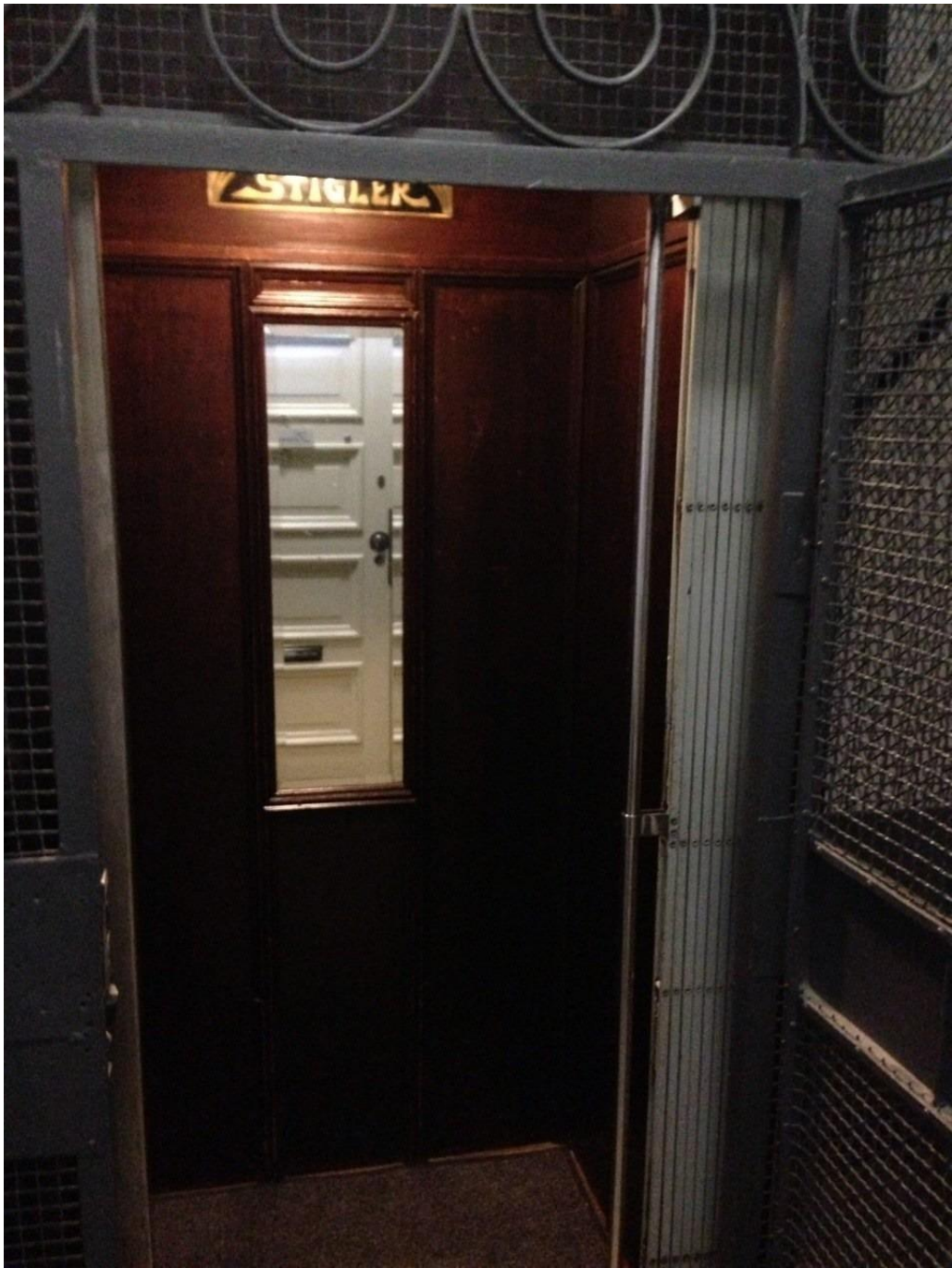
Kuva 1. Vanhanaikaiset veräjälliset hissit ovat pahin esimerkki turvalaitteiden puuttumisesta. Valokuva Niko Nieminen.
