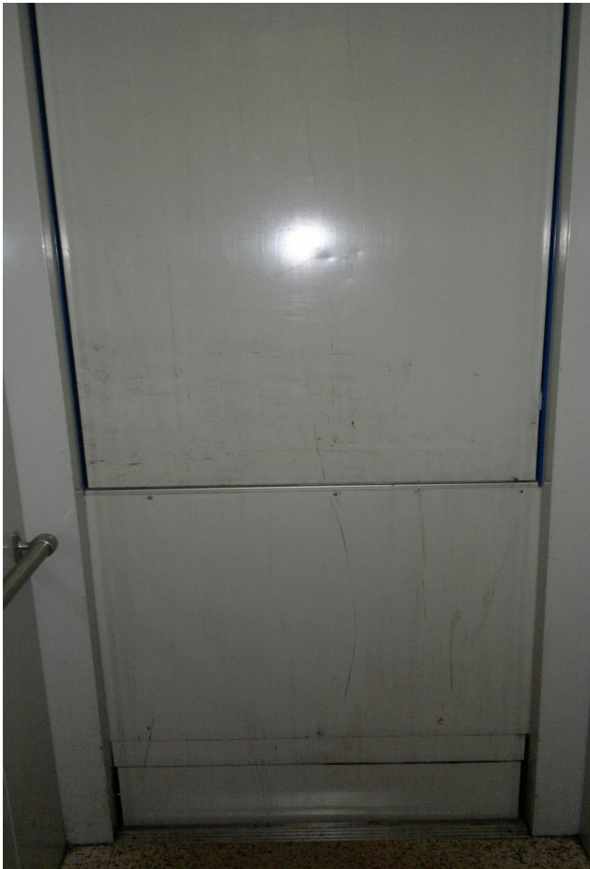
Kuva 3. Oveton hissikori aiheuttaa huomattavan turvallisuusriskin. Valokuva Niko Nieminen.
