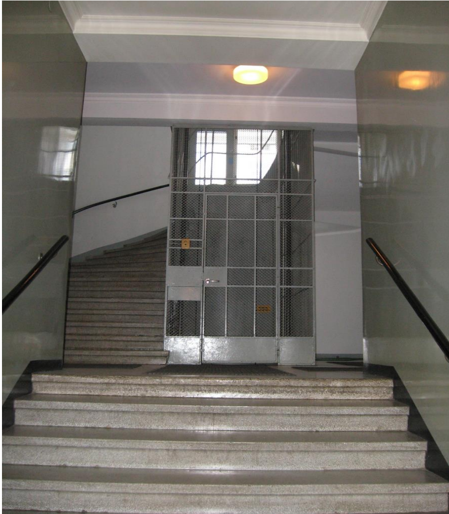
Kuva 5. Kuvan kaltaisessa tapauksessa hissiremontin yhteydessä porraskäytävän esteettisyyttä voitaisiin parantaa poistamalla portaat. Valokuva Niko Nieminen.
