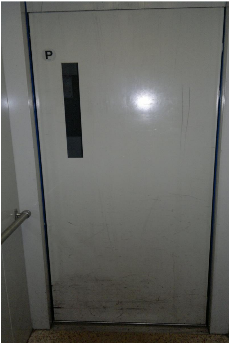
Kuva 2. Nykyään vielä hyvin yleinen mutta turvallisuudeltaan vanhanaikainen hissikori, jossa ei ole ovea. Valokuva Niko Nieminen.
