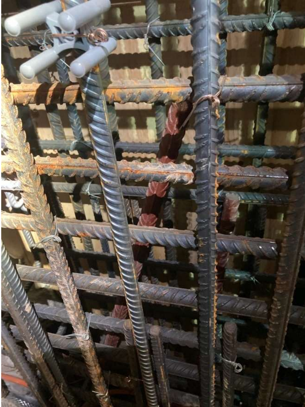
Kuva 20. Kalliopulppaus valmiin raudoituksen sisällä
