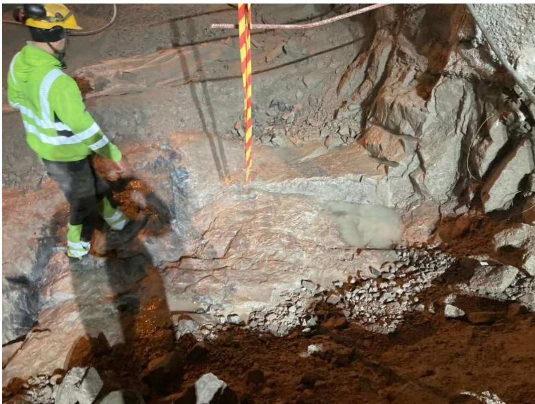
Kuva 6. Täysin puhdistettu kalliopinta.
