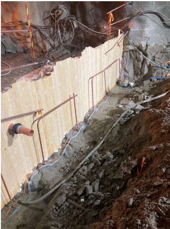
Kuva 22. Tulevan patoseinän kalliopulttaukset
