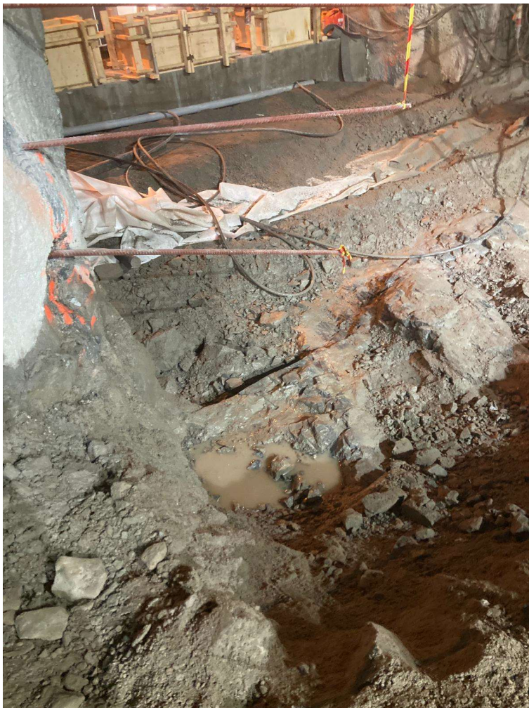
Kuva 3. Kaivanto kaivuutöiden jälkeen.
