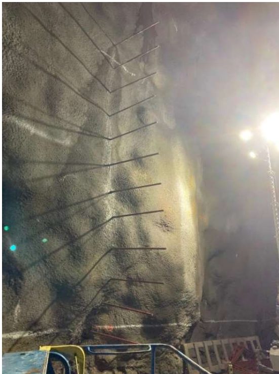
Kuva 18. Valmiit kalliopultit kallon seinästä
