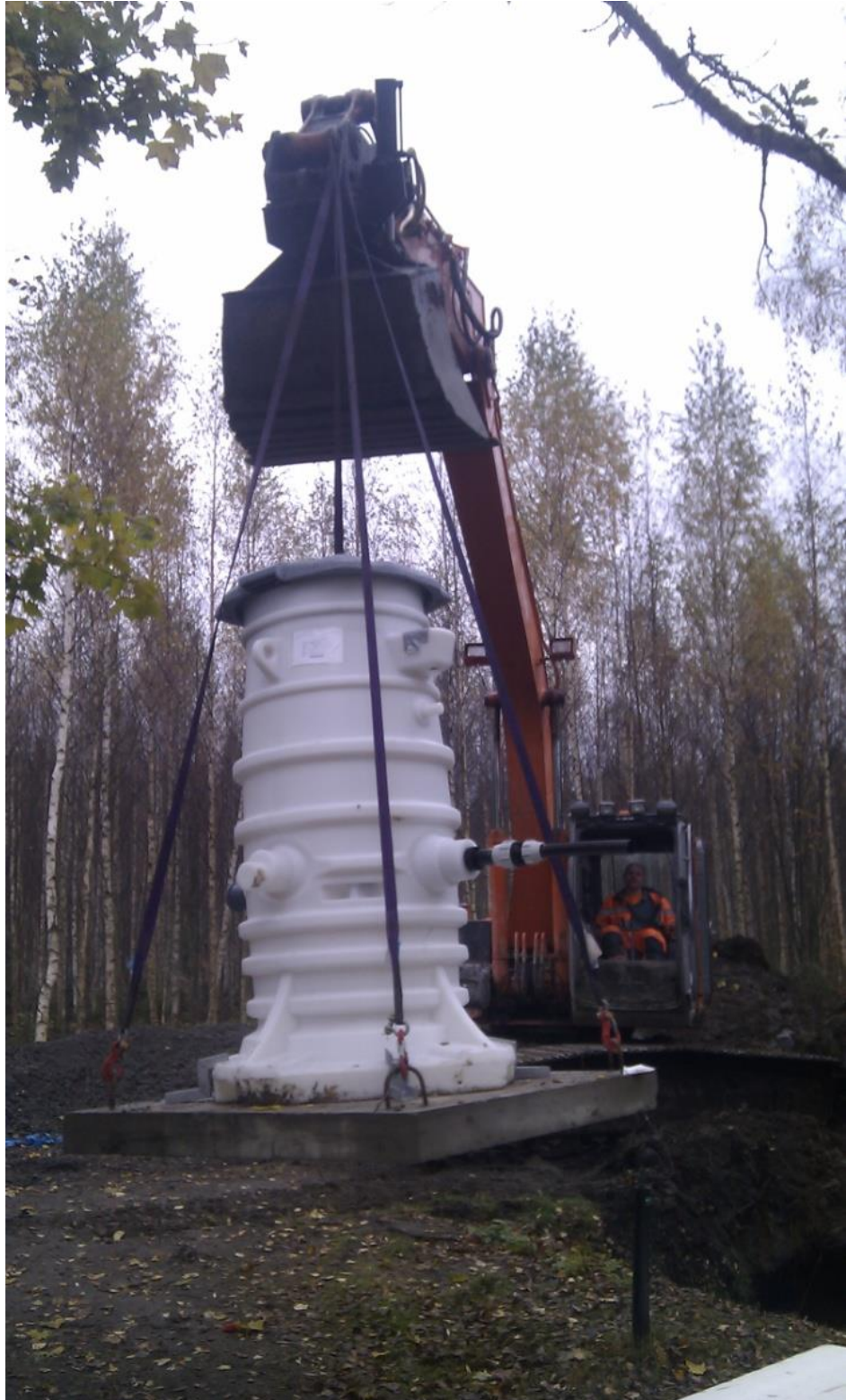
Kuva 18. Pumppaamon nosto pohjalaattoineen.
