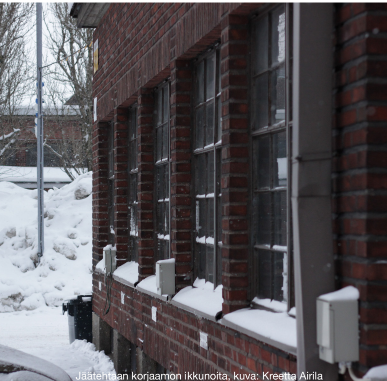
Jätehtaan korjaamon ikkunoita, kuva: Kreetta Airila
