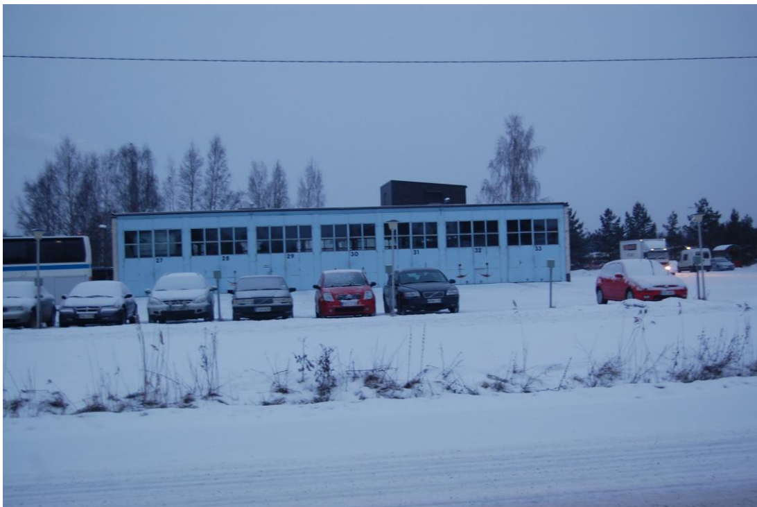
Kuva 2. Puinnintie 8 kalustohalli (Hämäläinen 2013)
