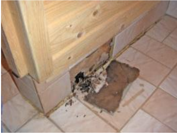
Kuva 5. Saunan ja pesuhuoneen välinen seinä (7, 29)
