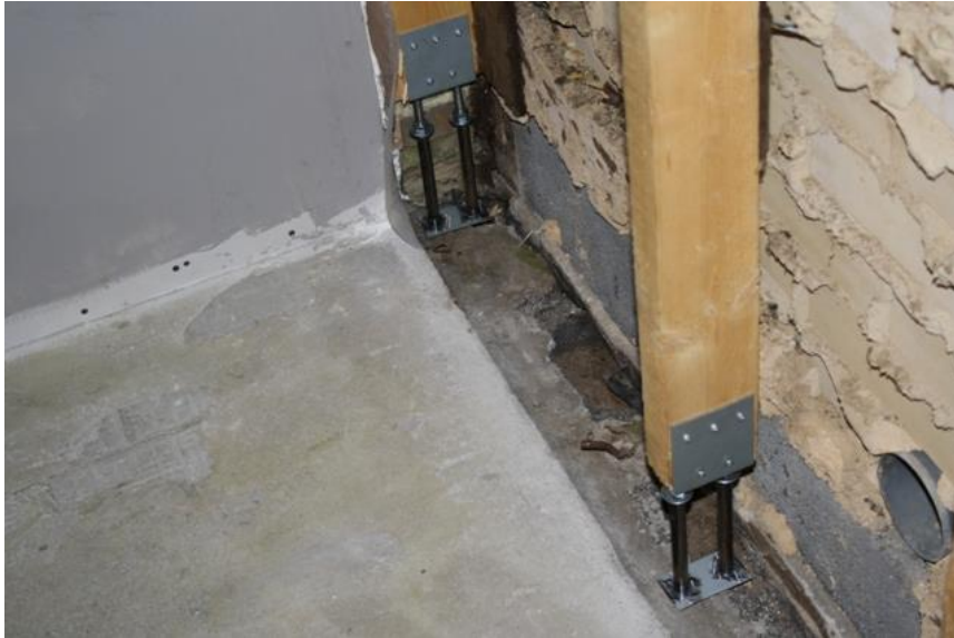
Kuva 9. Valesokkelikengät asennettuna ennen valua. (13)
