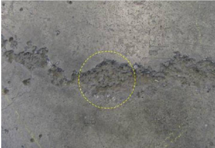
Kuva 25. Purkautunutta sirotepintaa. Ympyrän halkaisija on kuvassa 50 mm (Vahanen Oy 2010, 12).
