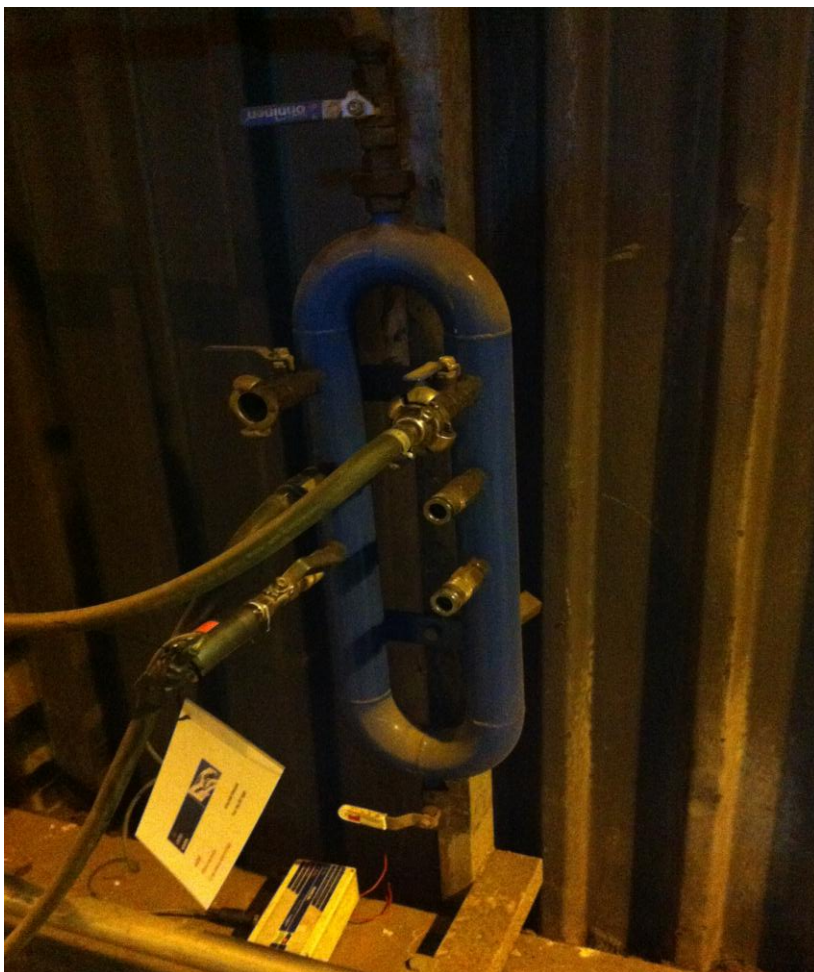
Kuva 11. R – kattilahiekan saattoilman mittauspiste (Juho Länne)
