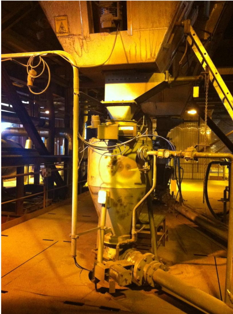
Kuva 8. RT – kattilan tuhkalähetin (Juho Länne)
