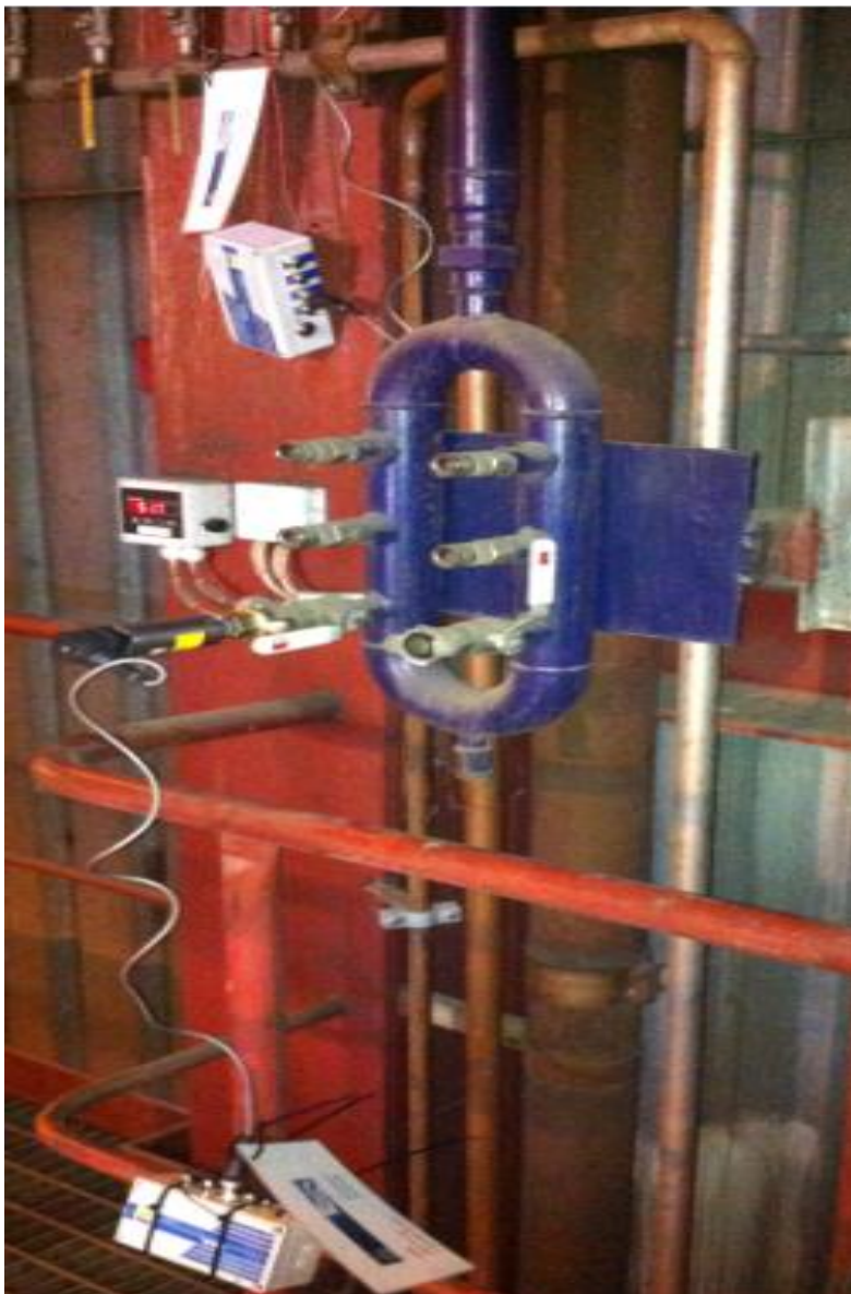
Kuva 10. Kalkkilaitteiden ja RT – kattilahiekan saattoilman mittauspiste (Juho Läme)
