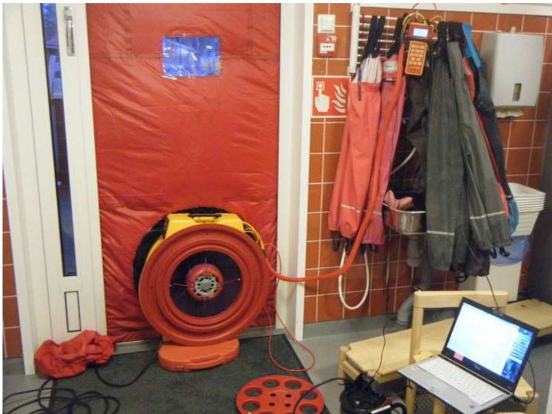
Kuva 10 Ilmatiiviysmittauksessa käytetyt tarvikkeet. Kuvassa BlowerDoor -ovikehys ja -muovi, Retrotec 1000 -puhallin ja sen ohjausyksikkö. Kannettavalla tietokoneella käytettiin Retrotecin FanTectic -ohjelmaa.
