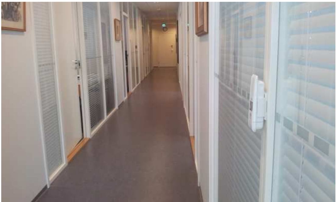
Kuva 5 Vesi-instituutin käytävän loppupäähän asennettu Wirepas-mittari.
