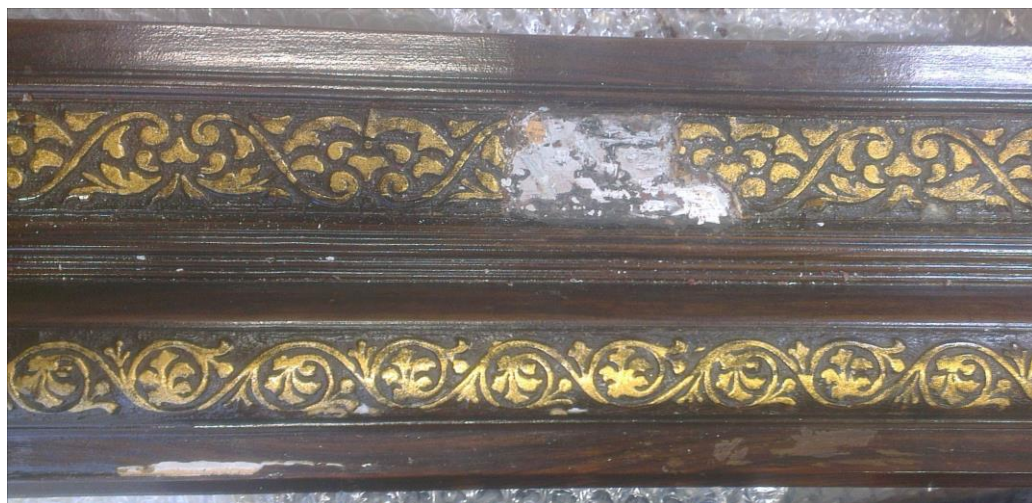
27. Kertaalleen korjattu osa irroitettu alalistasta, Taika Sahlstén
