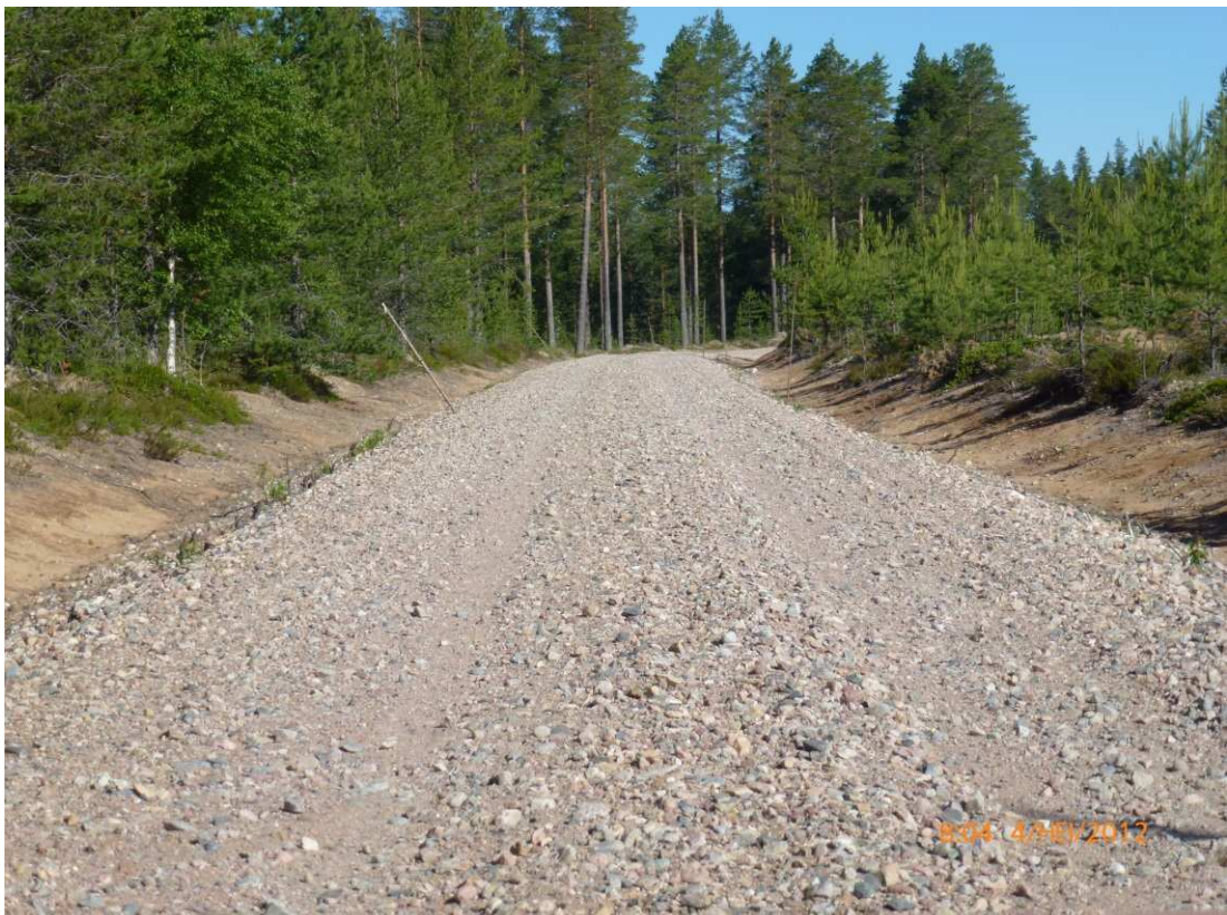
Kuvio 2. Peruskorjattu tie
