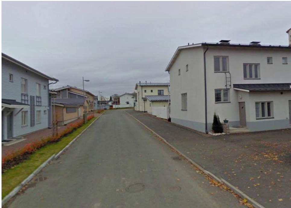
Kuva 15. Vanha-Lapio on tiiviin pientaloalueen katu Hämeenlinnan Visämäessä (Google 2009).
