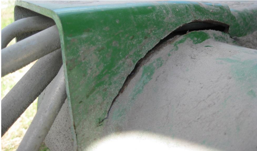
Kuva 11. Ratkeama aisan liitoskohdan päällä
