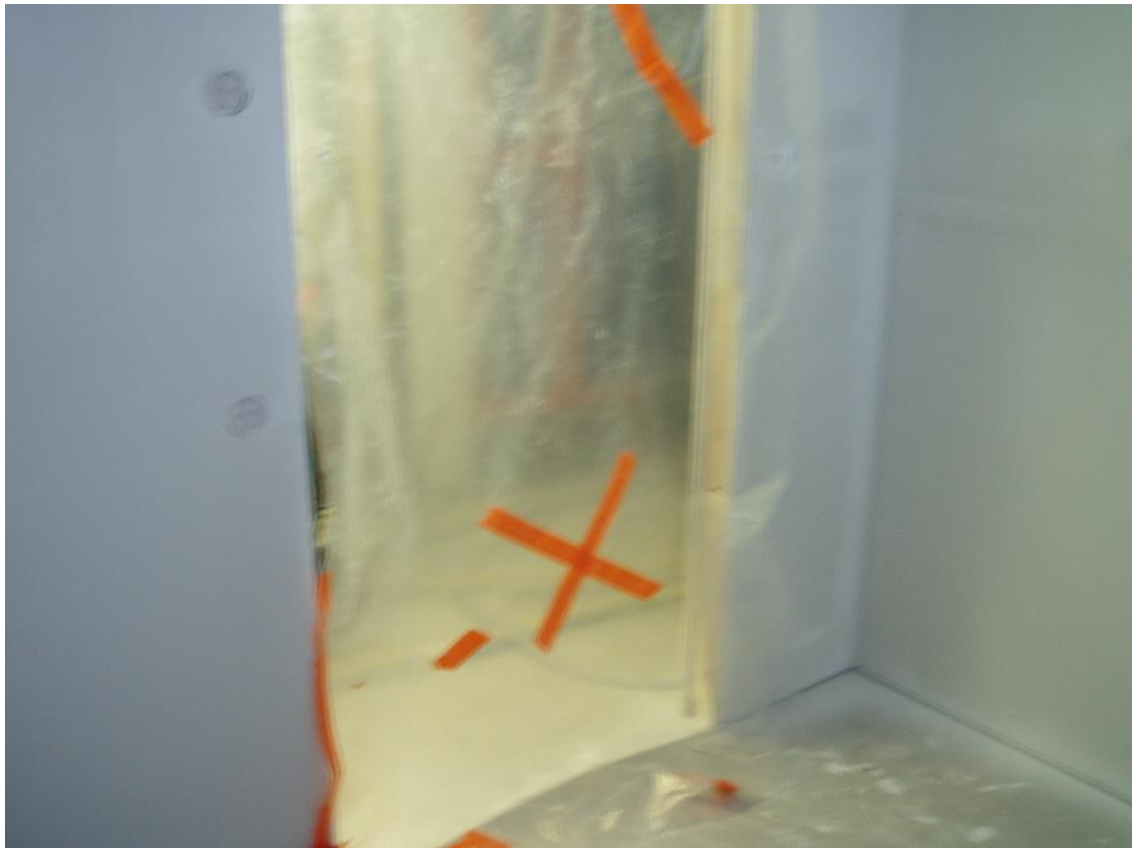
KUVIO 5. Siivottava tila suojattiin rakennusmuovilla mittausten ajaksi
