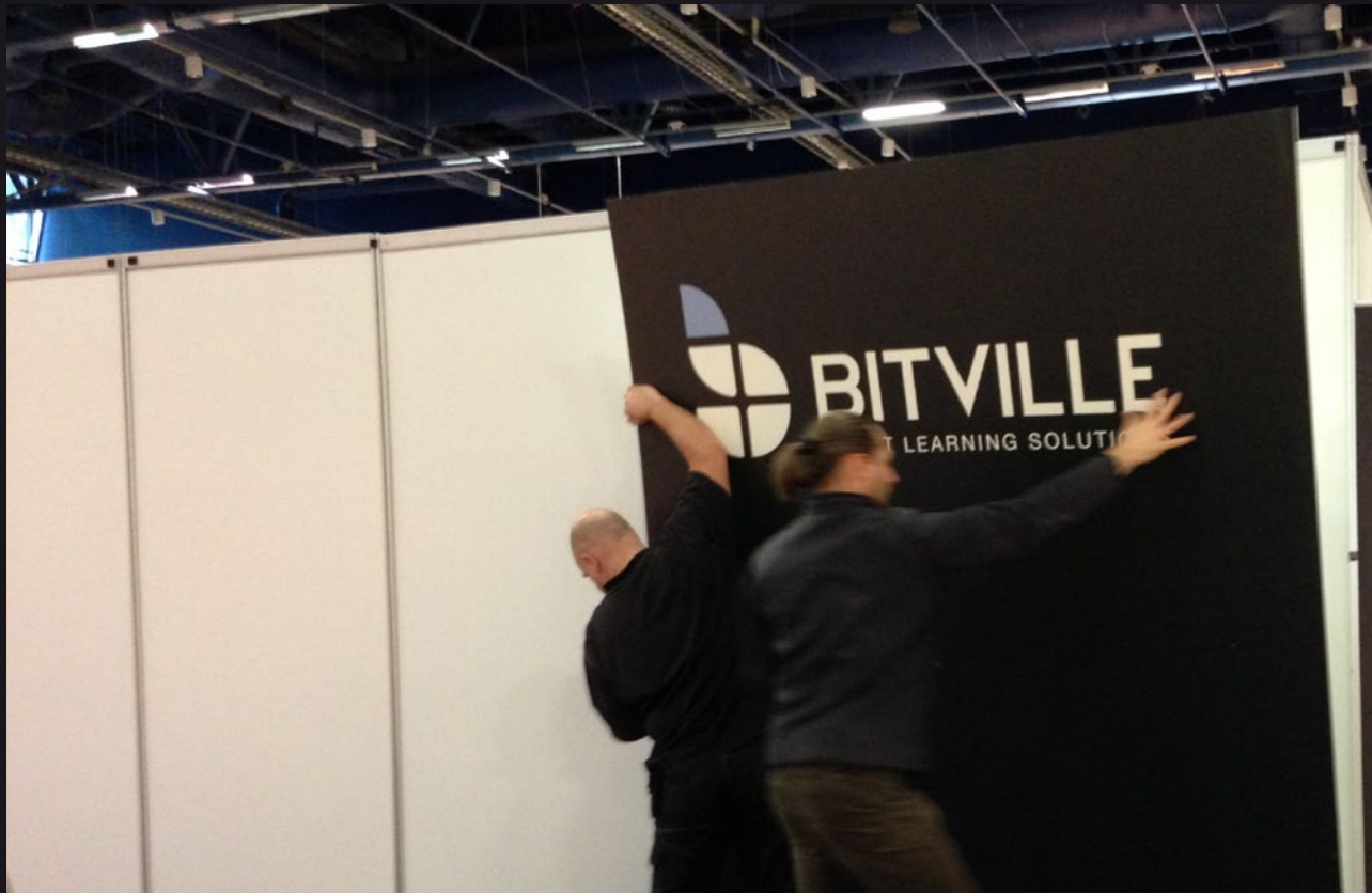
Kuva 35. Seinälevyt kiinnitetään mustilla tarranauhan palasilla.
