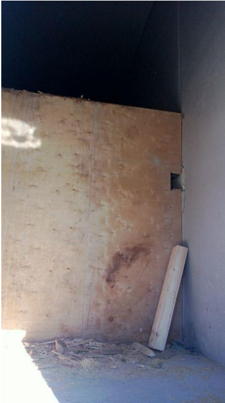
Kuvio 10. Massiivipuulla täytettävän siilon yläpuolelle asennetaan laajakuvapeili siilon sisäpuolelle näkemisen varmistamiseksi.
