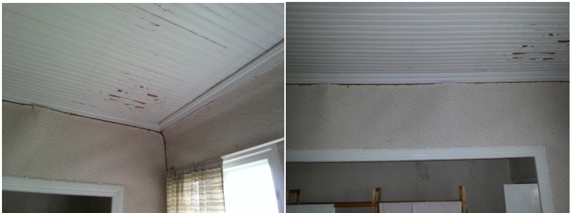
Kuvio 16 a ja b. Entisen emännänhuoneen katossa oleva vesivaurio ja irtonainen pinkopahvi
