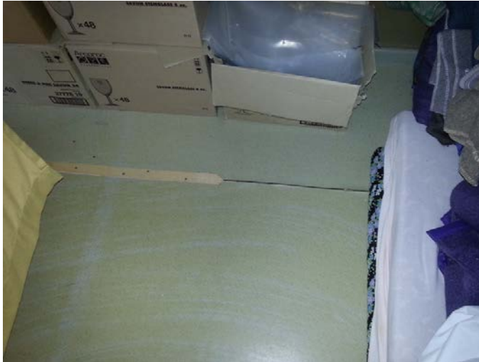
Kuvio 15. Toisen kerroksen makuuhuoneen irtonainen lattiapinnoite
