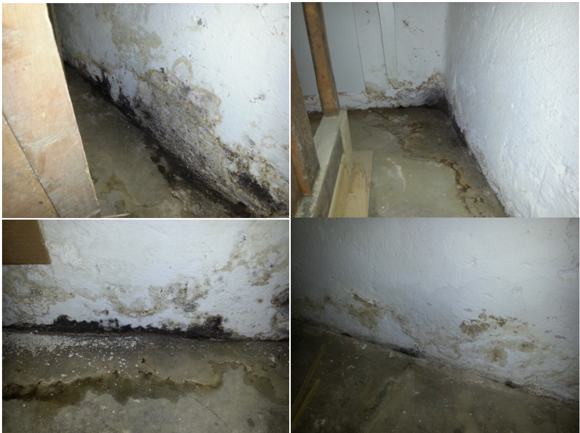
Kuvio 29 a, b, c ja d. Veistosalissa olevia kosteusvaurioita
