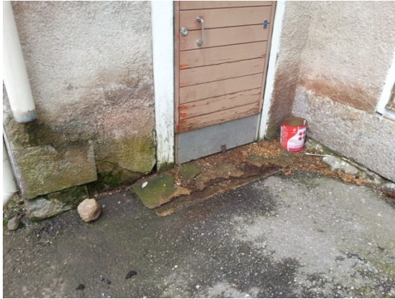
Kuvio 3. Kellarin sisäänkäynnin viereinen syöksyputki, josta puuttuu heittokäyrä
