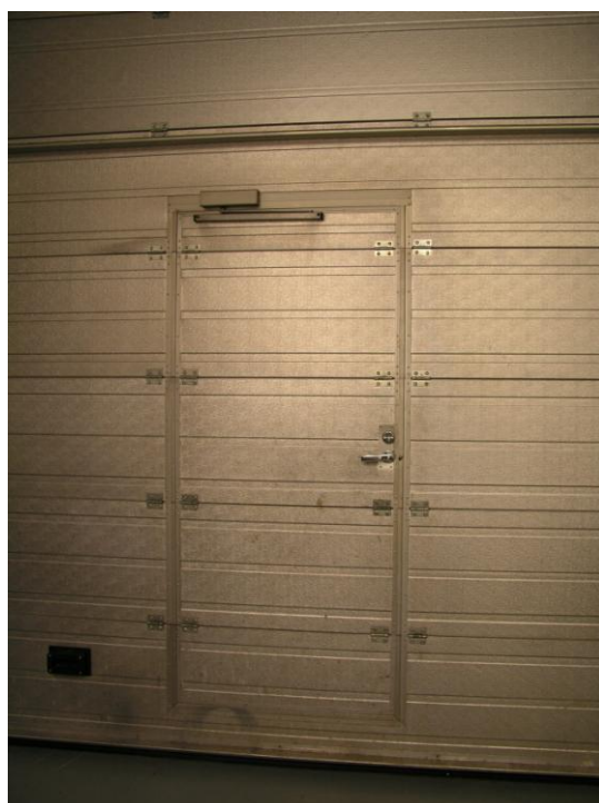
KUVA 16. Varaston ulko-ovi. (Alanen & Saviahde 2013)
