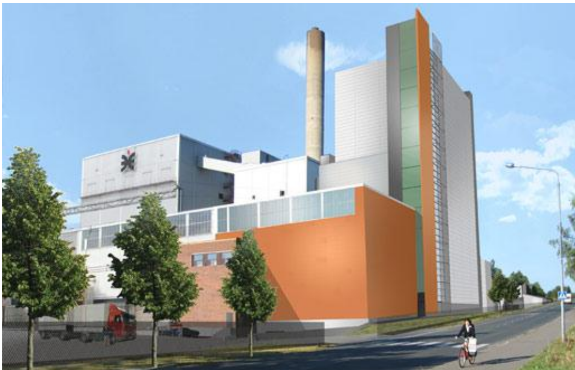
KUVA 2. HP3-lämmitysvoimalaitos (Kuopion Energia 2013.)
